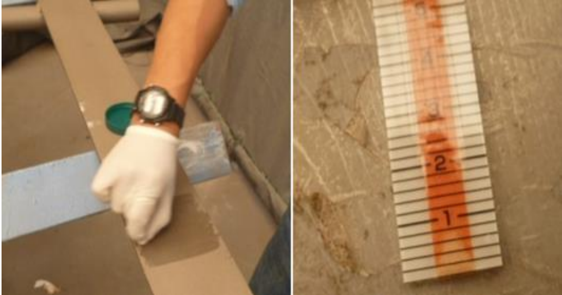
Figura 20. Inspección extracción de sales Fuente: elaboración propia
