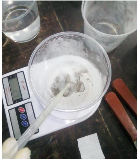
Figura 31. Agregado de agua a la mezcla de mortero seco Elaboración propia
