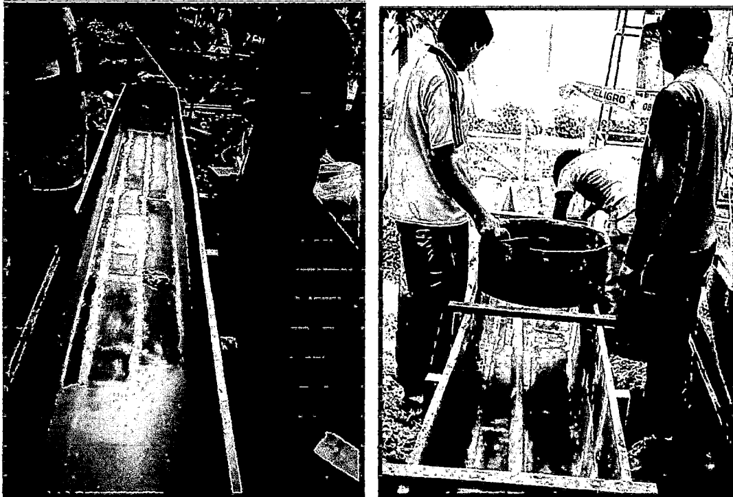
Figura 3.16. “Otras donde apreciamos la construcción del Humedal Piloto”
