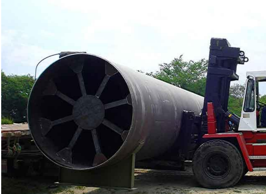
FIGURA N° 14: Proceso de construcción de tanque de almacenamiento
