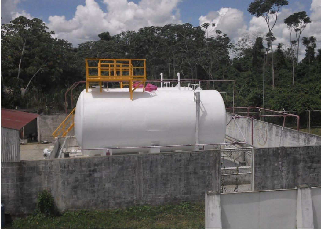
FIGURA N° 16: Vista panorámica de zona de tanques de almacenamiento
