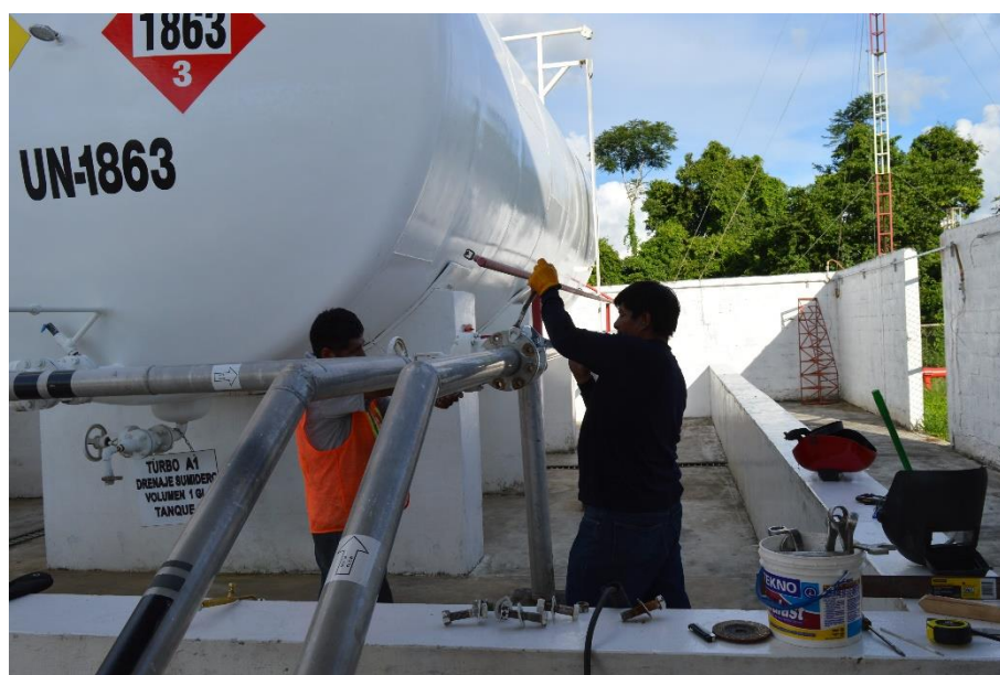
FIGURA N° 18: Construcción de líneas de tubería
