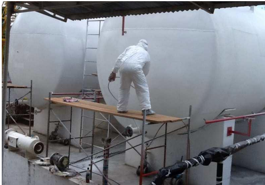
FIGURA N° 15: Proceso de arenado y pintado de tanque de almacenamiento
