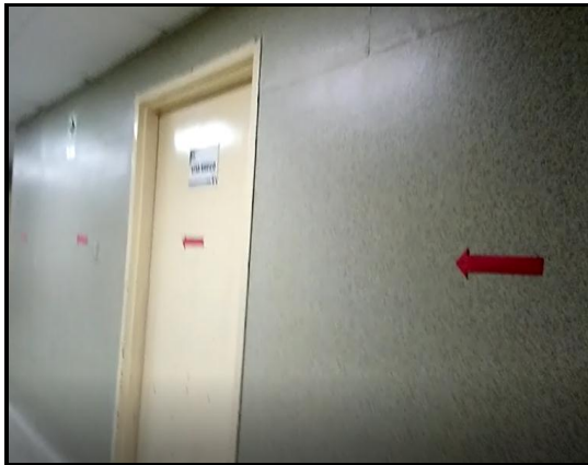
Puerta de ingreso del paciente Covid-19 señalización zona contaminada Roja
