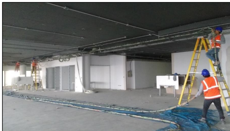
FIGURA N° 33. Tendido de cables eléctricos en bandejas tipo riel
