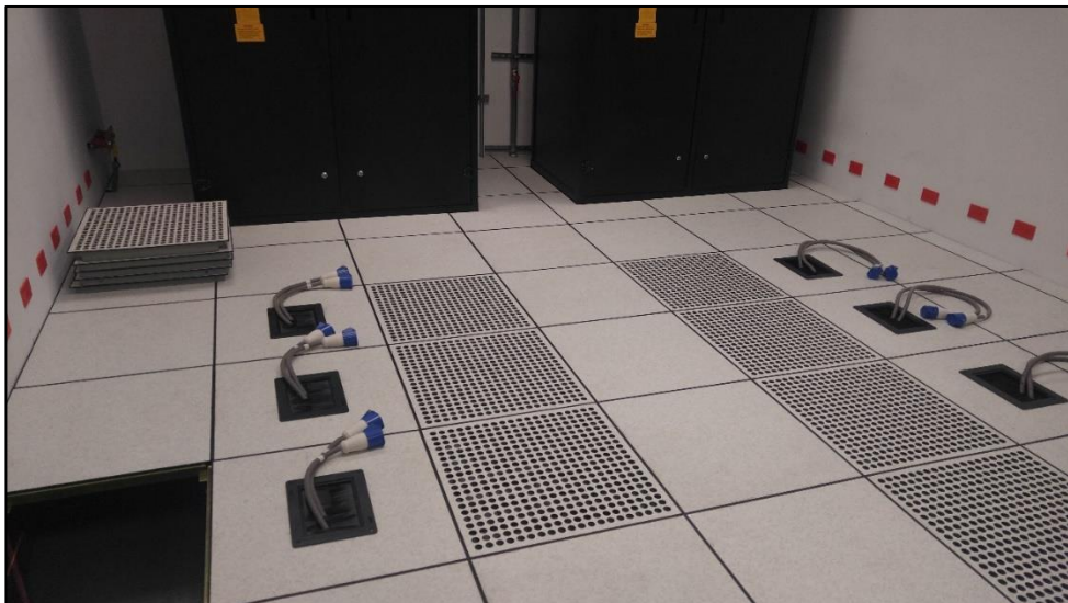
FIGURA N° 43. Instalación de tomacorrientes, Data Center
