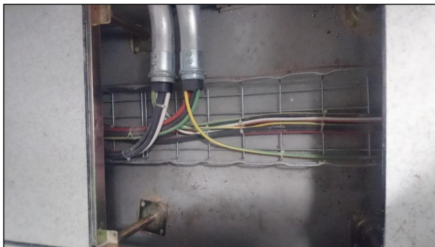
FIGURA N° 34. Tendido de cables eléctricos en tuberías Conduit EMT
