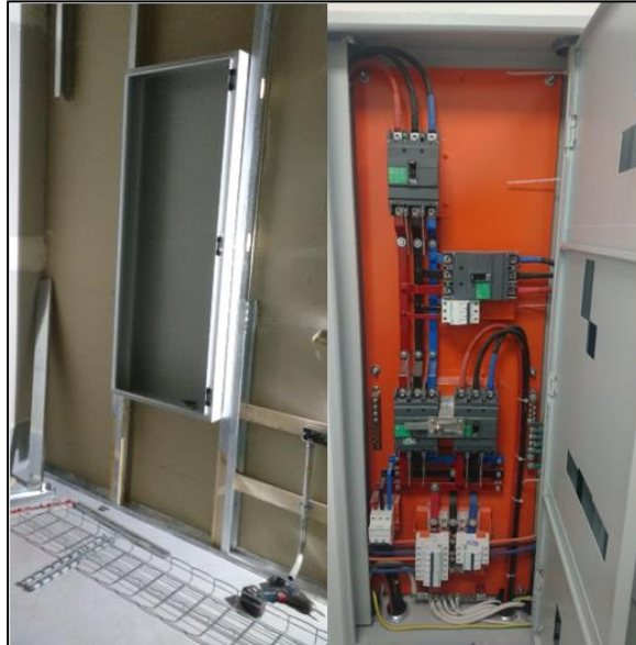
FIGURA N° 35. Montaje de Tablero Eléctrico de By Pass - Computo
