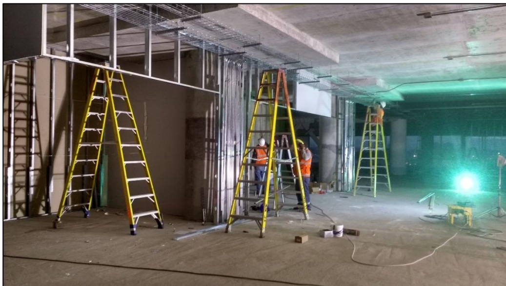
FIGURA N° 31. Distribución de bandeja tipo riel
