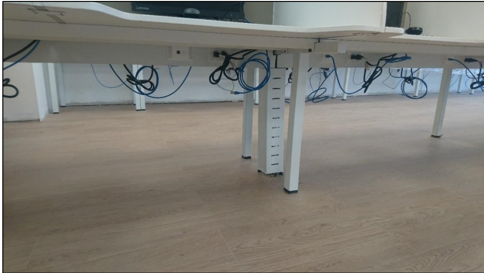
FIGURA N° 42. Instalación de tomacorrientes, centro de computo
