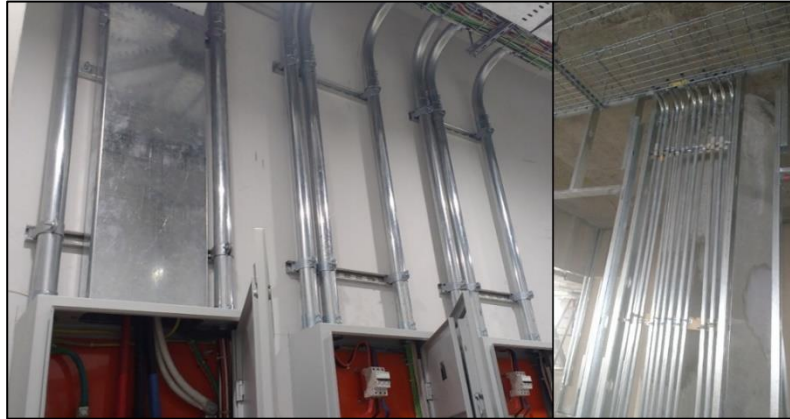
FIGURA N° 32. Distribución de tubería Conduit tipo EMT
