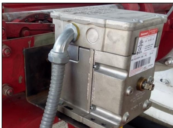
Figura 67: Base y fijación al quemador para Motor modutrol
