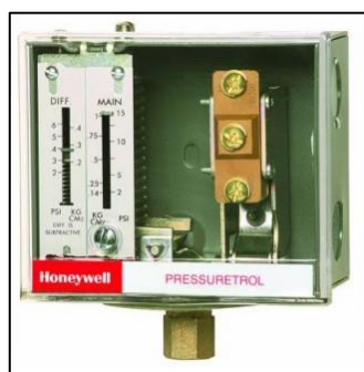
Figura 9: Presostato de seguridad Honeywell
