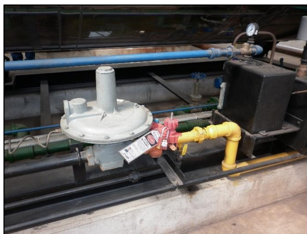
Figura 70: Válvula de gas natural con etiqueta y candado de bloqueo
