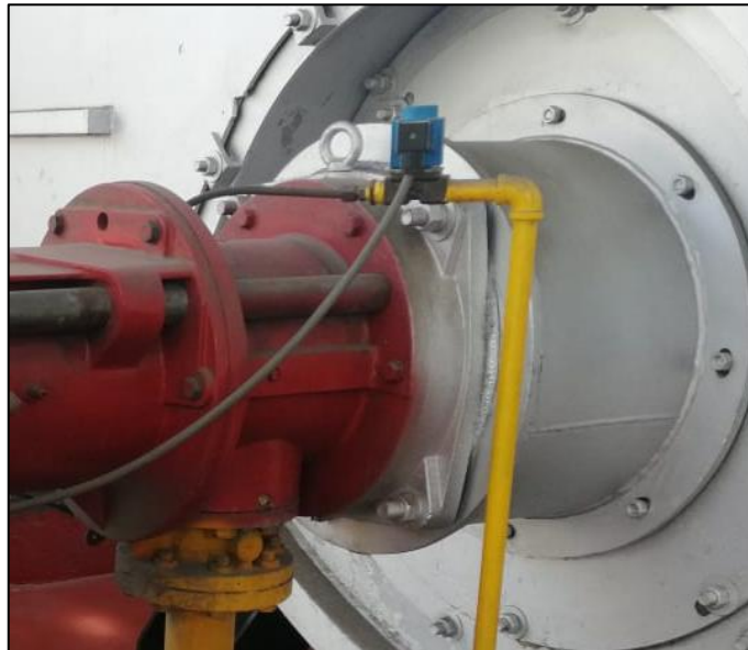
Figura 61: Instalación de Válvula solenoide Danfuss de ½”
