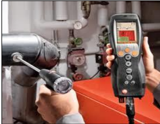
Figura 17: Medición de gases
