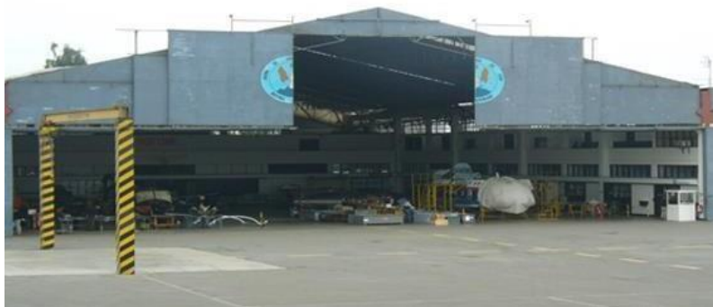
Figura I-1. Hangar de mantenimiento
