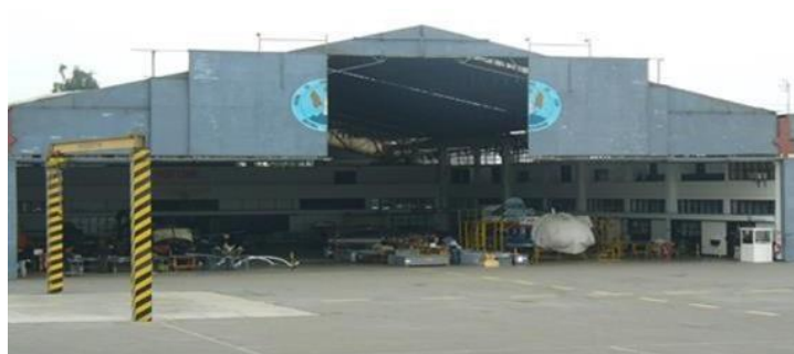
Hangar de mantenimiento
