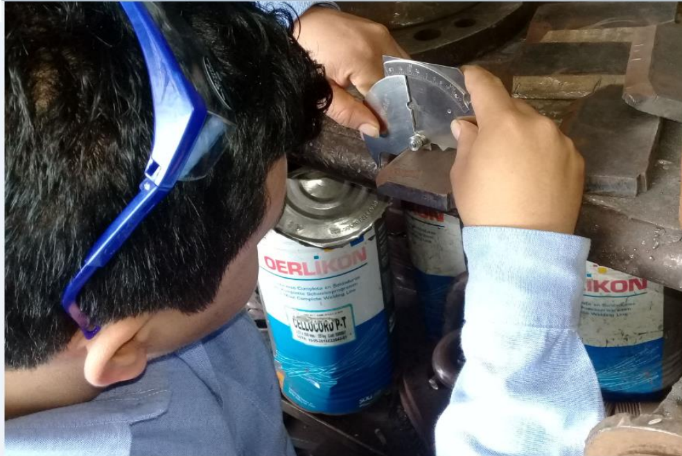
Figura N° 4.7 Inspección de las uniones soldadas
