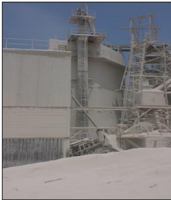
Figura N° 9 Elevador de cangilones
