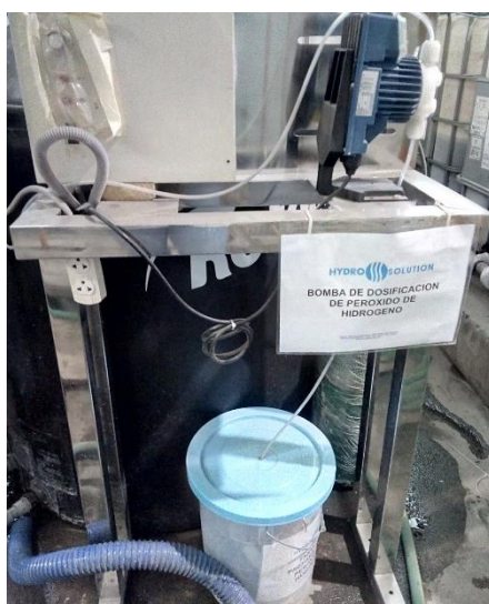
Figura 53. Dosificación de peróxido de hidrógeno y generador de ozono
