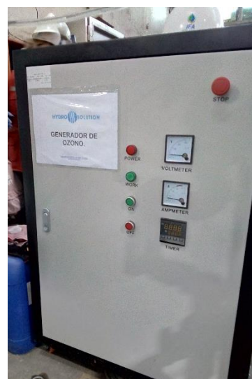
Figura 53. Dosificación de peróxido de hidrógeno y generador de ozono
