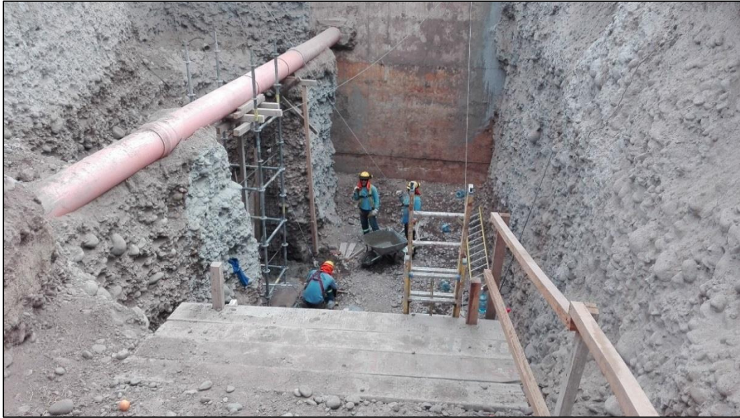
Fotografía 1 – Trabajos de excavaciones
