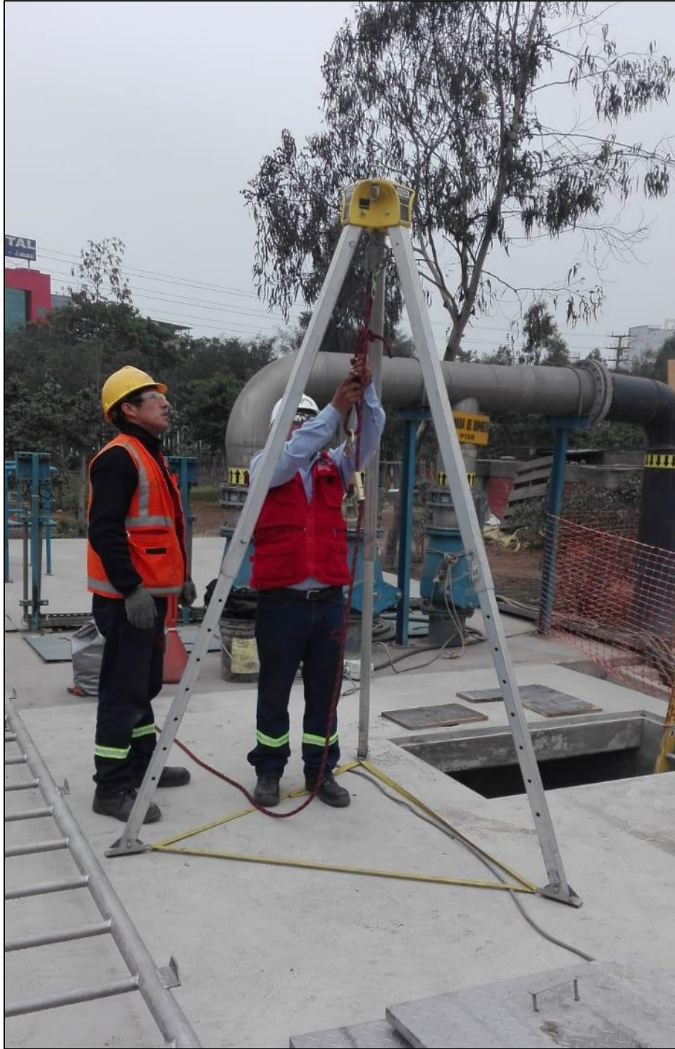
Fotografía 6 – Capacitaciones en rescate de espacio confinado
