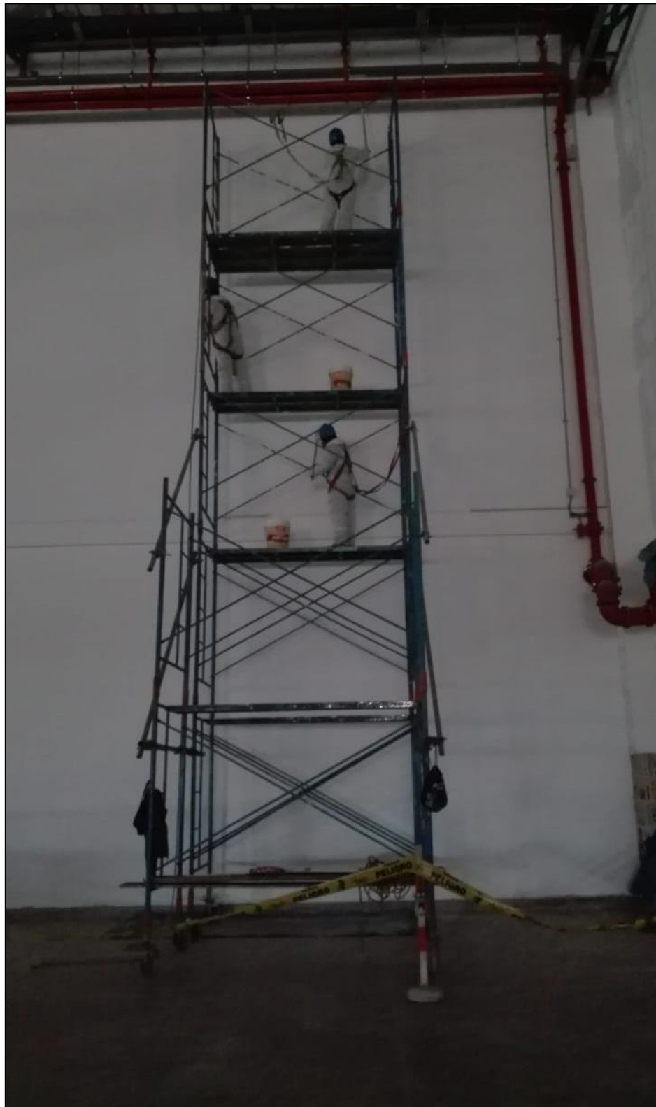
Fotografía 3 – Trabajos en altura
