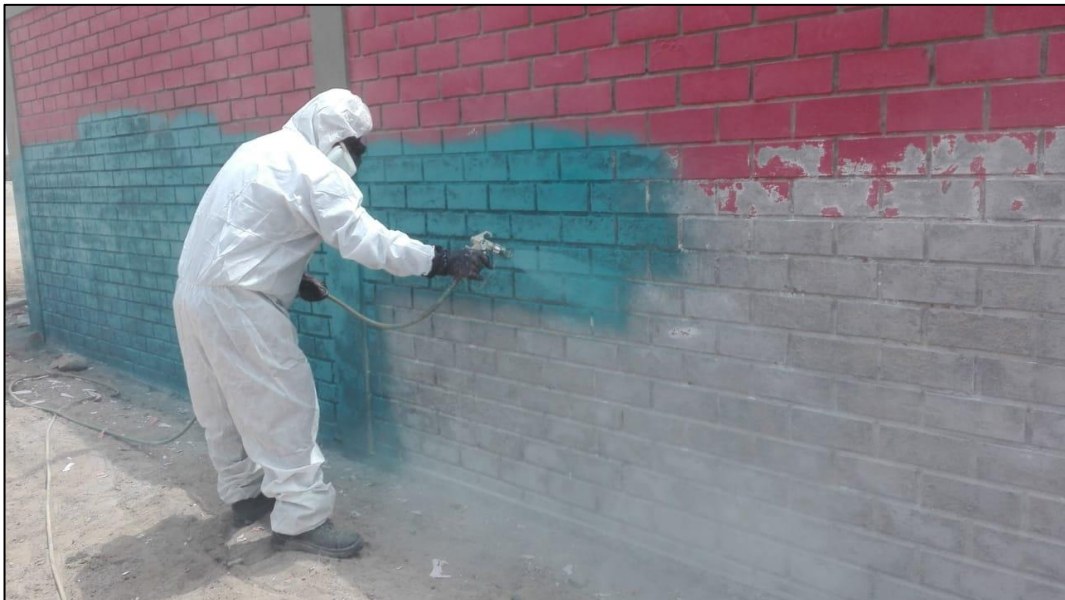
Fotografía 2 – Trabajos de pintado de muros
