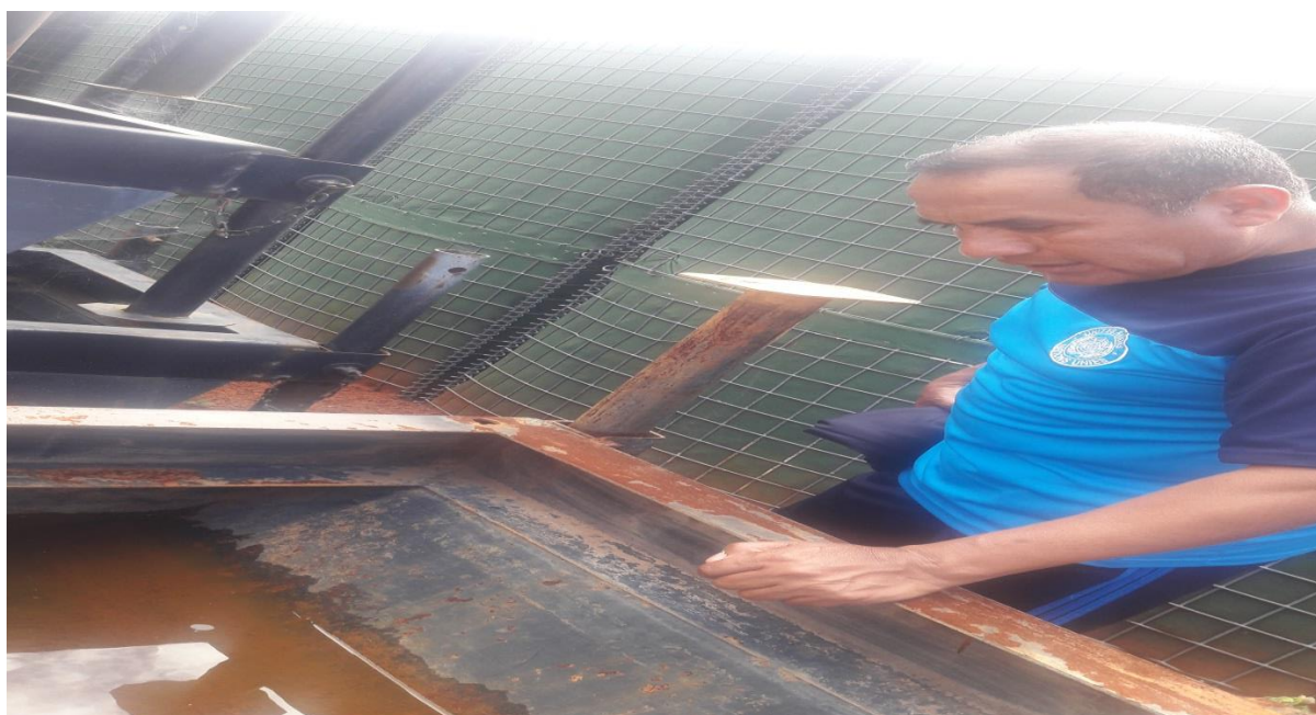
ACUMULOS DE AGUA EN OTROS RECIPIENTES DE LOS TALLERES
