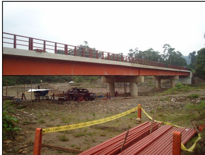
Gráfico N° 1.1 Montaje de Puente Chaquimayo
