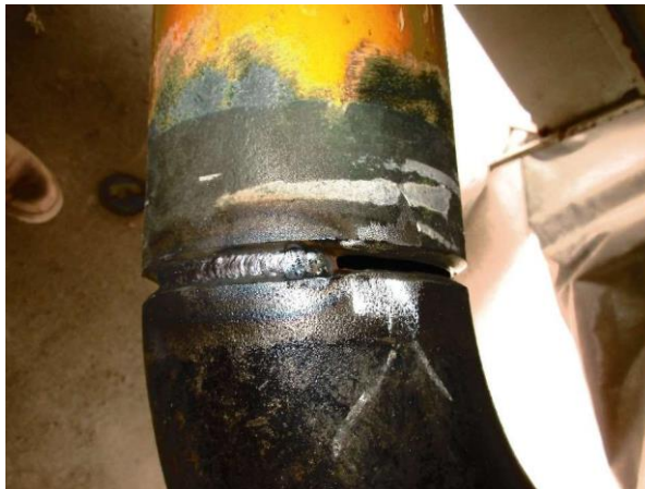
FIGURA 4.17 PASE DE RAÍZ Y RETIRO DE PUNTO DE FIJACIÓN
