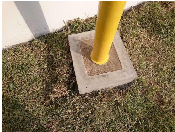
FIGURA 4.12 MURETE DE PROTECCIÓN DE TRANSICIÓN DE PE/ACERO
