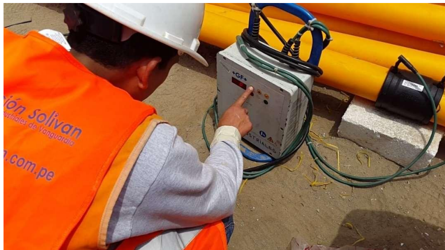
FIGURA 4.7 CONEXIÓN A LA FUENTE DE PODER Y SETEO DE PARÁMETROS
