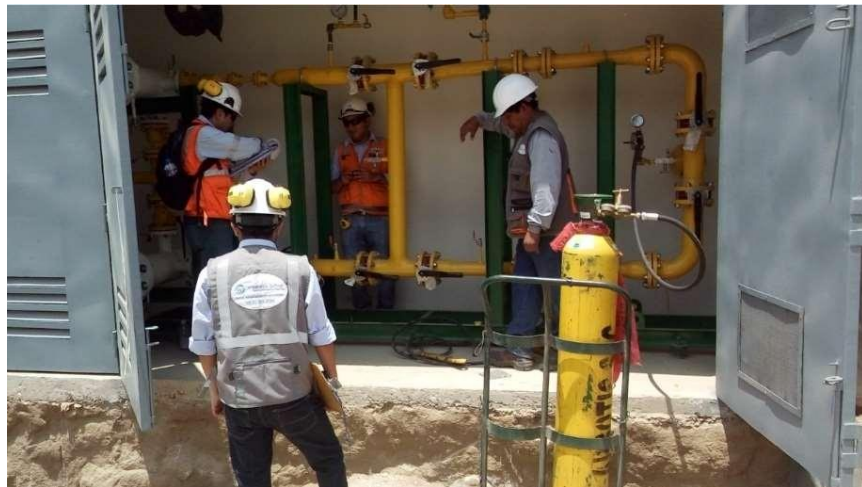
FIGURA 4.42 PRUEBA DE HERMETICIDAD - ESTACIÓN PRIMARIA
