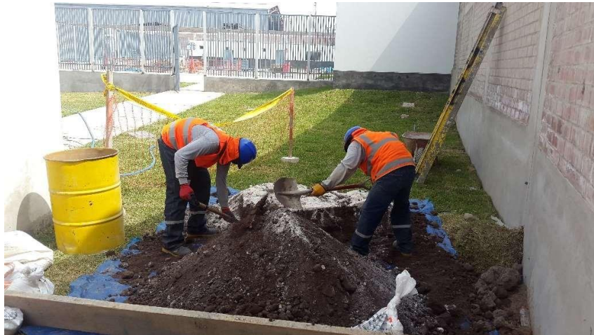
FIGURA 4.30 CONSTRUCCIÓN DE POZO A TIERRA PARA ESTACIÓN PRIMARIA
