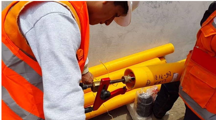
FIGURA 4.6 RASPADO Y BISELADO DE TUBERÍAS DE HDPE
