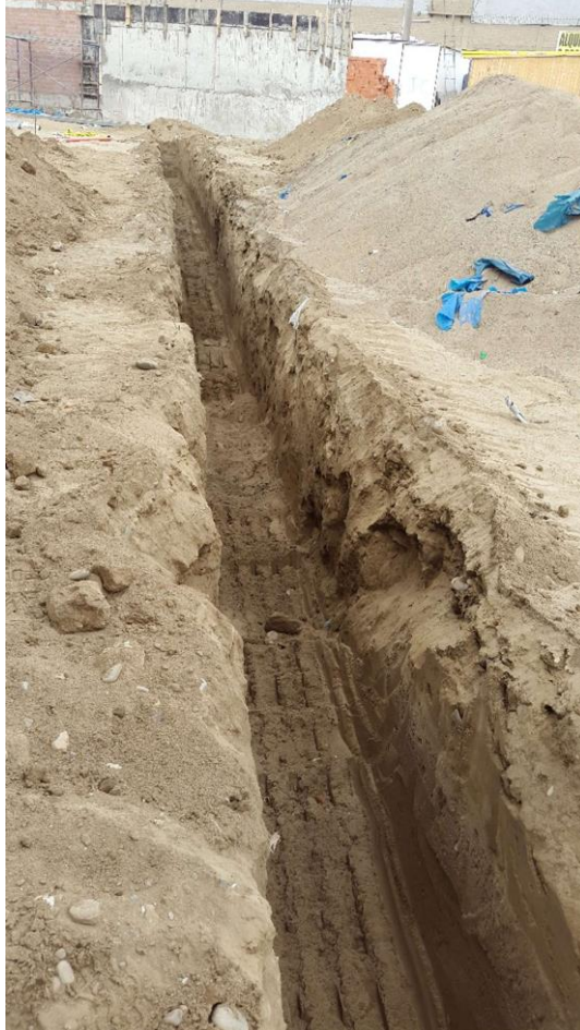
FIGURA 4.5 ZANJA PARA TUBERÍA DE HDPE
