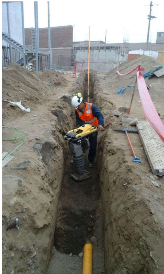
FIGURA 4.10 RELLENO Y COMPACTADO DE ZANJA
