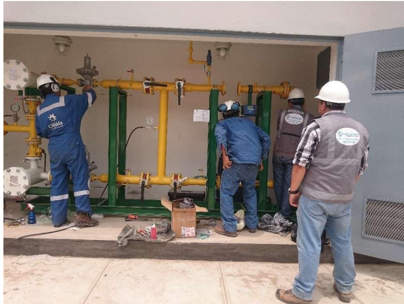
FIGURA 4.44 HABILITACIÓN DE SUMINISTRO DE GAS NATURAL
