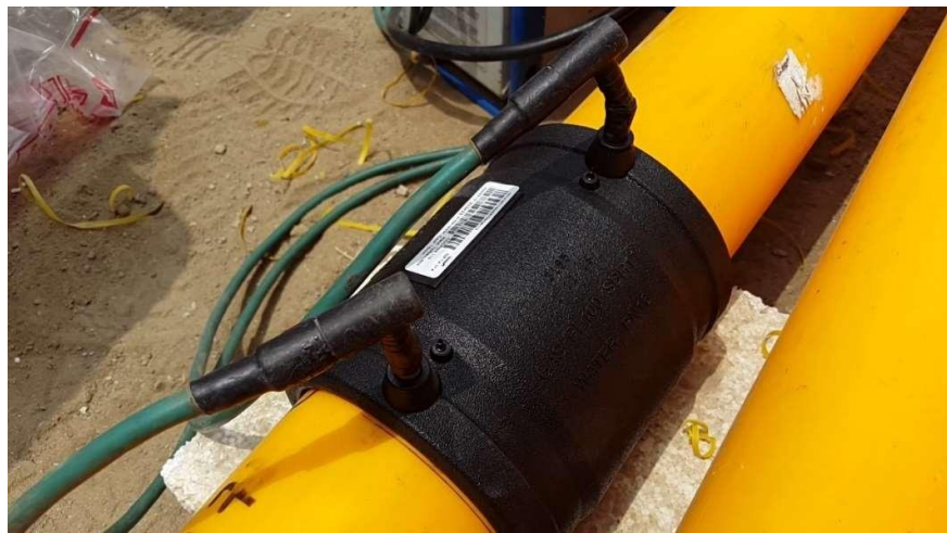
FIGURA 4.8 ELECTROFUSIÓN DE TUBERÍA Y ACCESORIO DE UNIÓN
