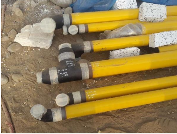
FIGURA 4.16 PROTECCIÓN DEL BISEL PREVIO A LA SOLDADURA
