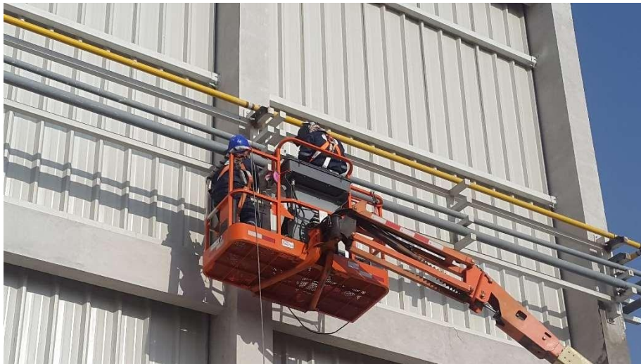
FIGURA 4.19 SOLDEO DE VARILLONES EXTERIORES
