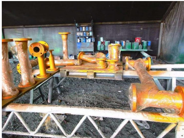
FIGURA 4.15 EMPAQUETADO DE SPOOLS DE ESTACIÓN PRIMARIA
