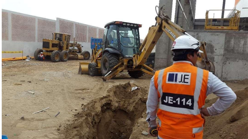
FIGURA 4.4 EXCAVACIÓN DE ZANJA
