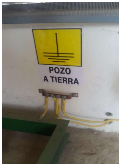
FIGURA 4.31 CONEXIÓN A TIERRA DE ESTACIÓN PRIMARIA
