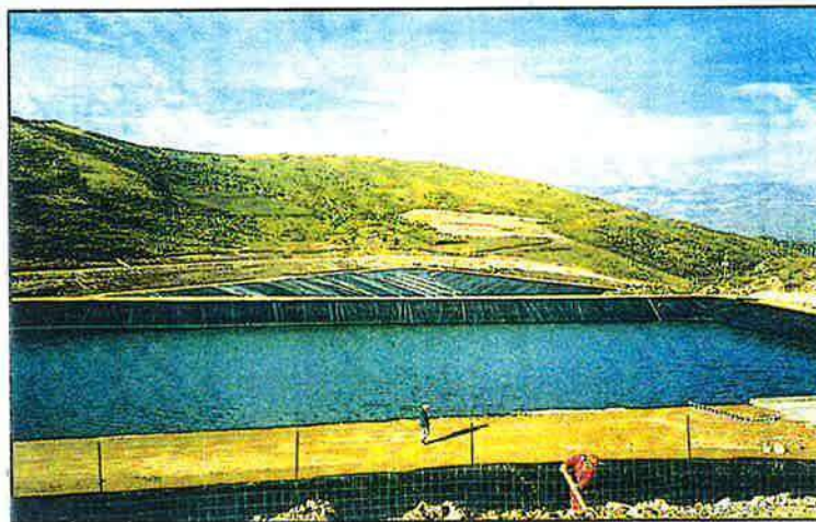
Poza de excedentes prevista para emergencias y protegida por geomembrana de alta densidad, con 1.5 milímetros de espesor
