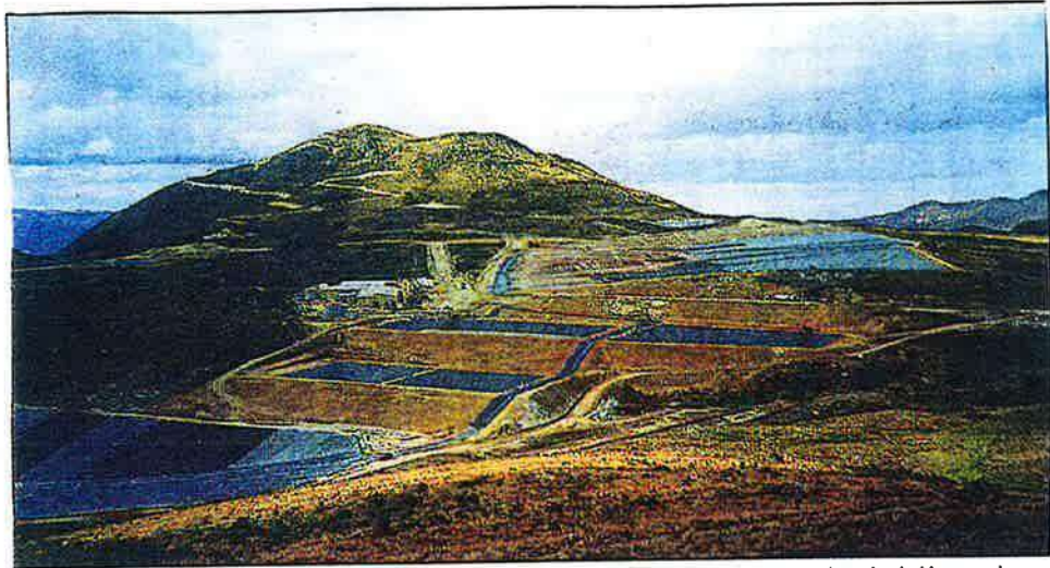
Los flamantes «pads» de lixiviación que comenzaron a producir en 1997. La roca es similar a la de Yanacocha
