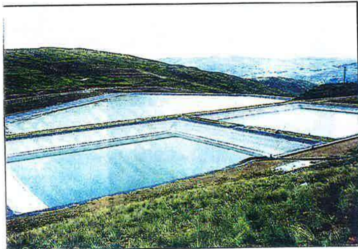
Pozas de solución rica e intermedia, con promedios de 4.5 gramos de oro por metro cúbico. Al fondo, poza de excedentes
