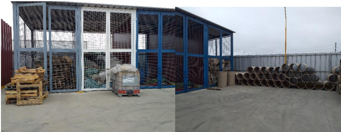
Zona de almacenamiento de Residuos recuperados
