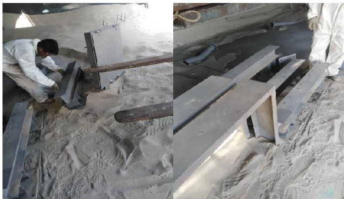
Figura 66. Limpieza de estructuras mediante chorro abrasivo.
