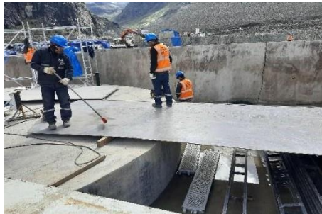
Figura 58. Limpieza de planchas previas al soldeo.
