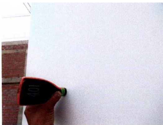
Figura 67. Aplicación de 4 mils de pintura e capa base.
