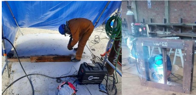
Figura 62. Proceso de soldadura GMAW.
