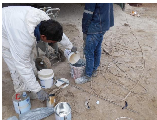
Figura 69. Preparación de pintura según proporción de mezcla indicada.
