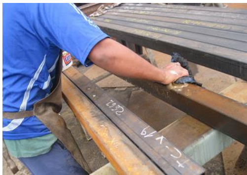
Figura 65. Limpieza previa de materiales.
