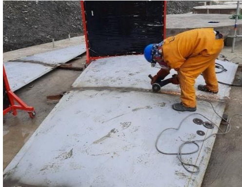
Figura 56. Biselado de planchas de acero ASTM A36 en taller.
