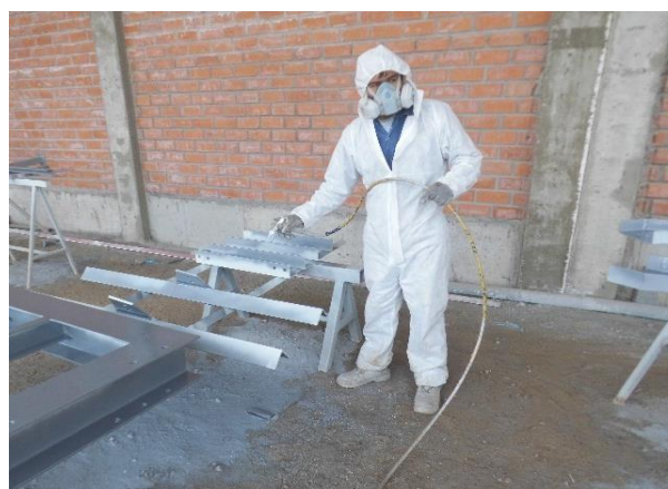
Figura 70. Aplicación de pintura a estructuras en taller.
