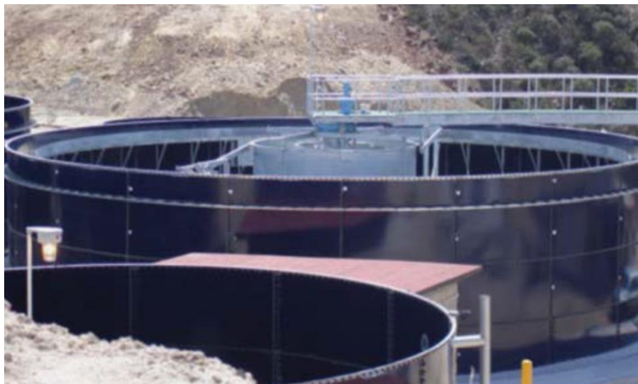
Figura 15. Tanque vertical sin techo.
