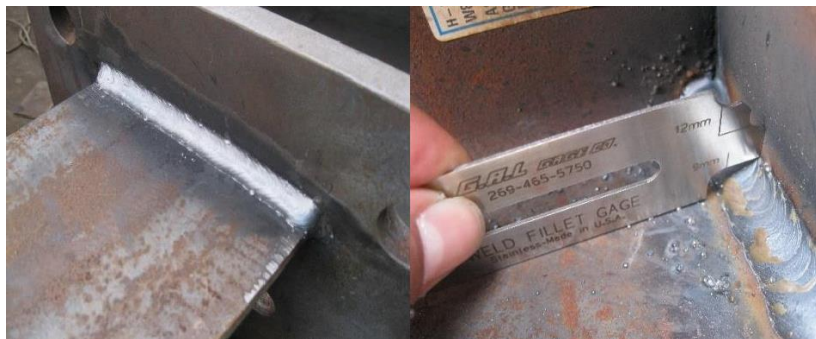
Figura 63. Inspección visual en taller. Certificado de calibración en anexo 5.
