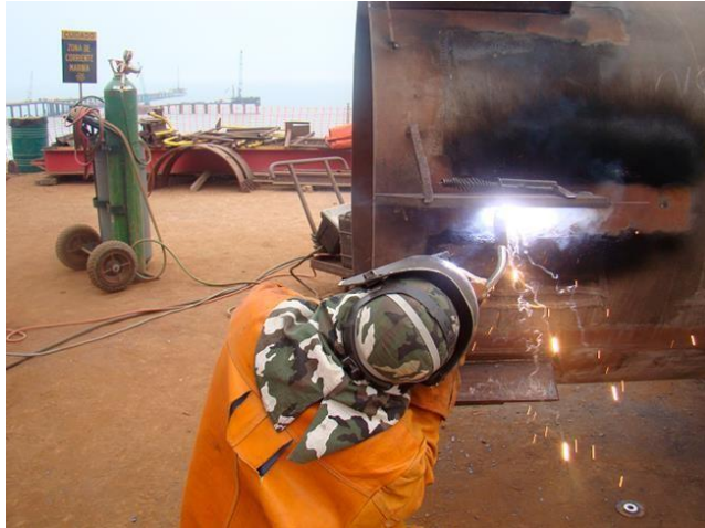
Figura 21. Servicios especiales de soldadura. Tomada de Soldexa, 2021. Recuperado de:
