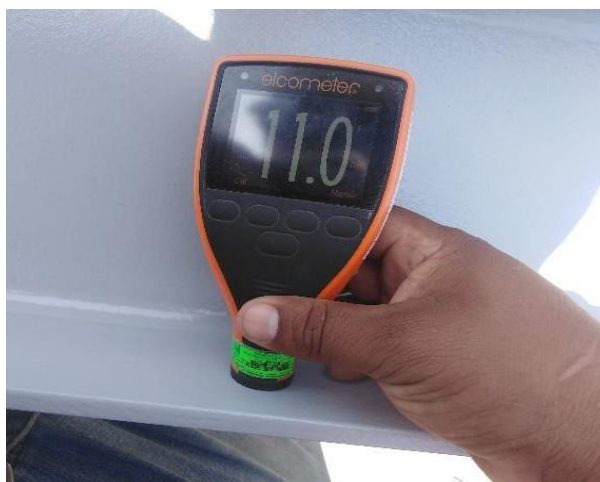
Figura 68. Aplicación de 7 mils de pintura en capa intermedia.
