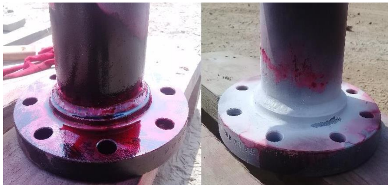
Figura 64. Inspección por tintes penetrantes en taller. Certificado de calidad en anexo 6.
