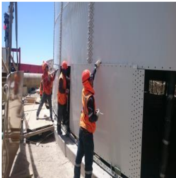
Imagen N°43 Distribución de planchas del 7to anillo.
