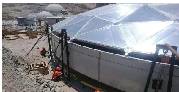
Imagen N°24 Empernado y remachado de pernos de planchas de techo domo
