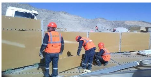
Imagen N°20 Torqueo de pernos en unión de planchas de casco
