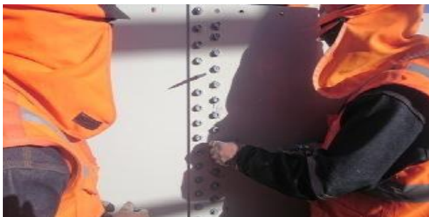
Imagen N°14 Uniones empernadas de planchas de casco
