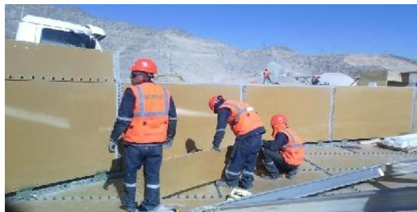
Imagen N°18 Distribución de planchas de casco
