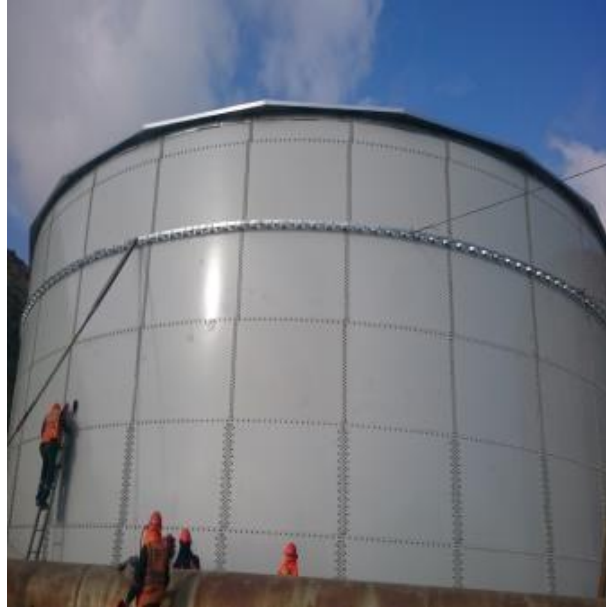
Imagen N°40 Unión emperrada de planchas del 6to anillo.
