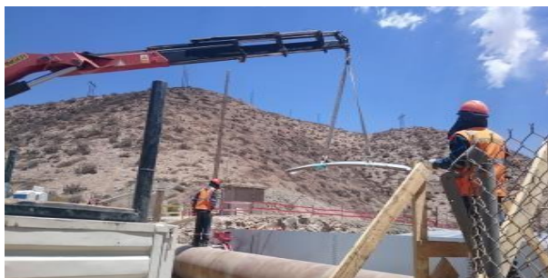
Imagen N°13 Distribución de planchas de casco
