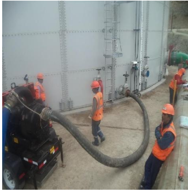
Imagen N°52 Llenado de tanque con bomba
