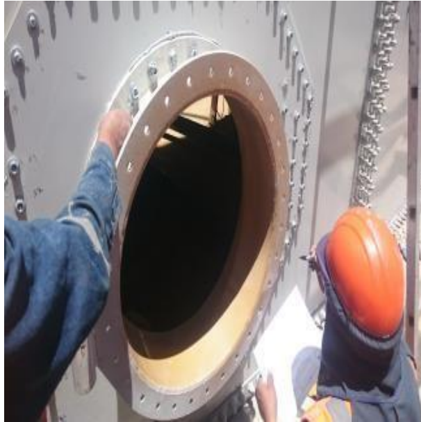
Imagen N°50 Montaje de boquilla emperrada de 30”.
