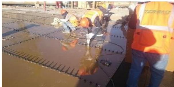
Imagen N° 7 Torqueo de pernos de pancha de fondo
