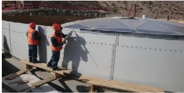
Imagen N°15 Sellado de uniones empernadas de planchas de casco
