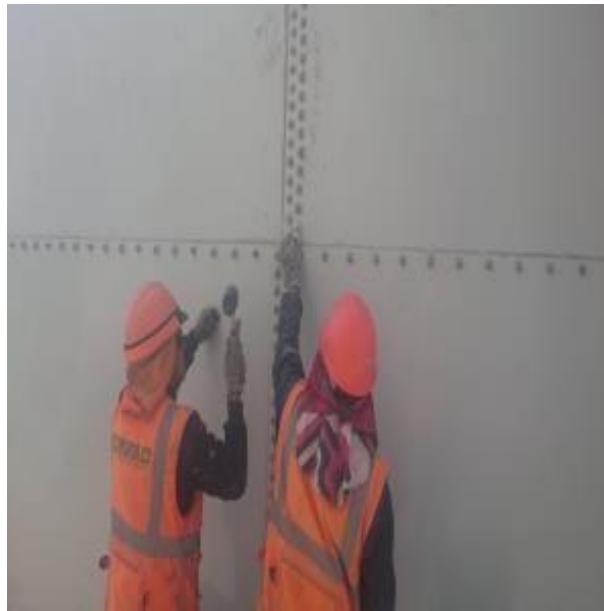
Imagen N°33 Torqueo de planchas de casco 4to anillo.
