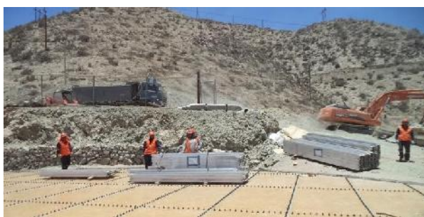
Imagen N°8 Traslado de estructuras de aluminio del techo tipo domo
