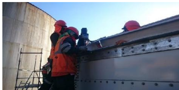
Imagen N°16 Torqueo de pernos de planchas de casco 2do anillo
