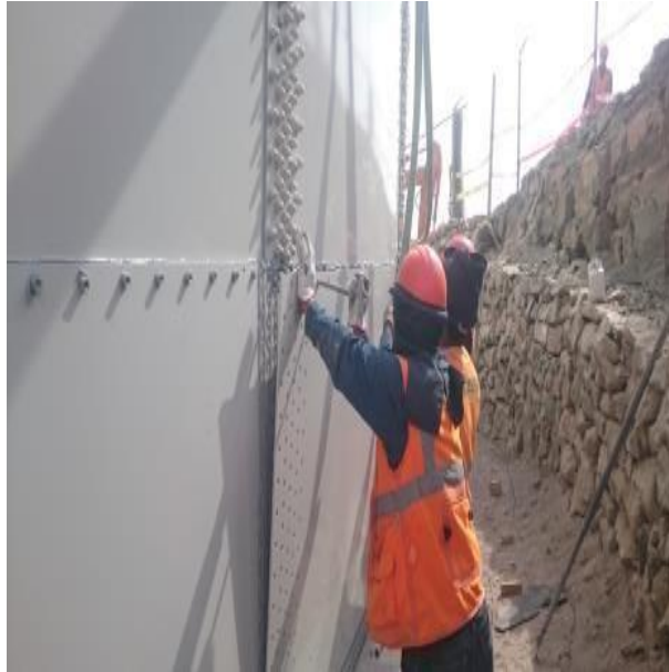
Imagen N°48 Unión emperrada de planchas para el 8vo anillo.
