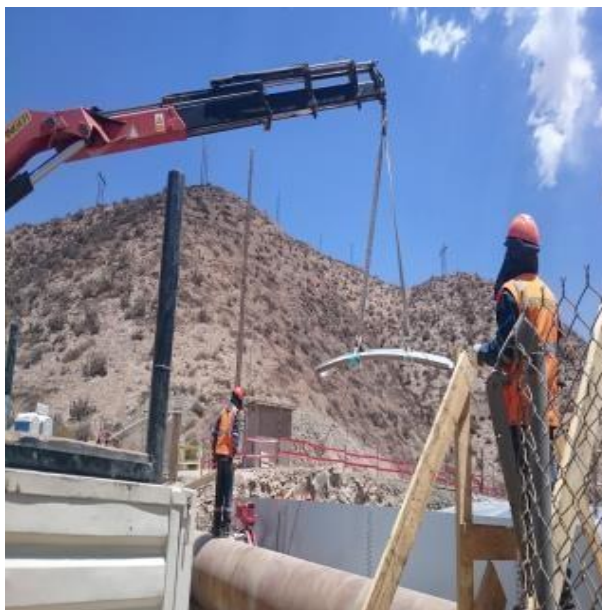
Imagen N°31 Distribución de planchas en anillo de casco.
