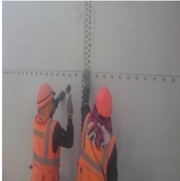
Imagen N°45 Torqueo de planchas de casco 7mo anillo.
