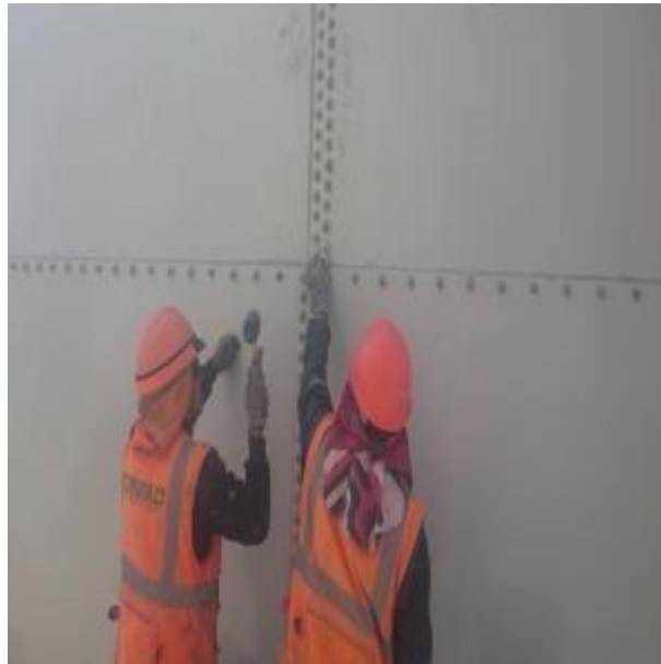
Imagen N°37 Torqueo de planchas de casco 5to anillo.
