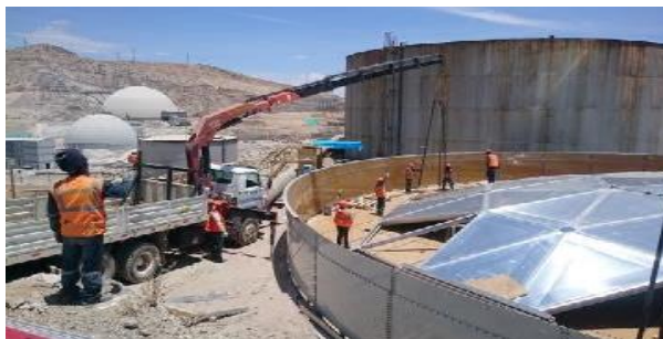
Imagen N°23 Instalación de planchas de aluminio en techo tipo domo.
