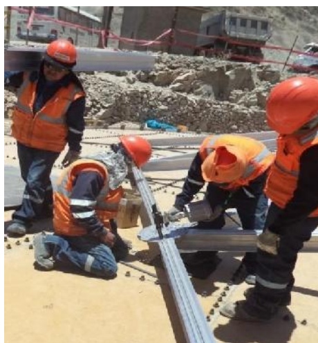
Imagen N°11 Remachado de pernos de aluminio con Pistola HUCK
