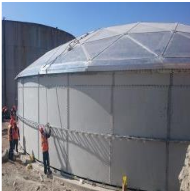
Imagen N°28 Uniones empernadas en anillo de casco.
