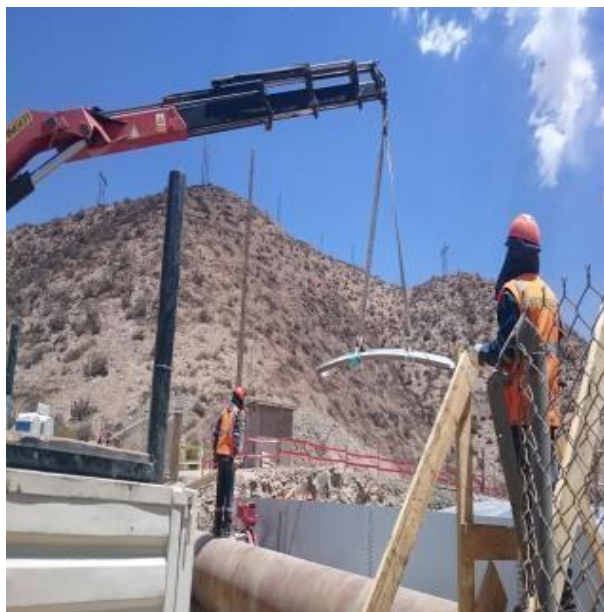
Imagen N°38 Carguío y traslado de planchas de casco 6to anillo.
