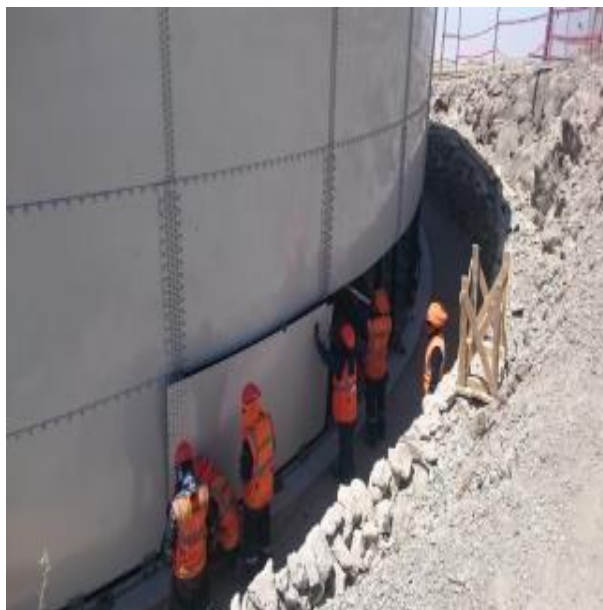
Imagen N°39 Distribución de planchas del 6to anillo.
