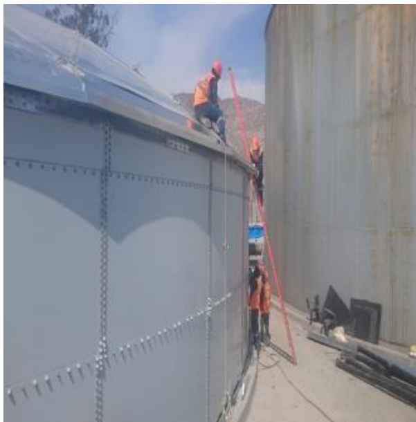
Imagen N°29 Torqueo de uniones empernadas en anillo de casco.
