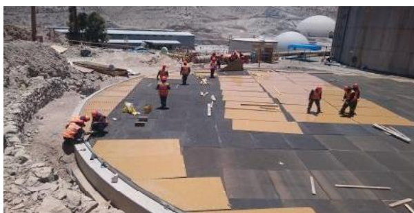
Imagen N°3 Distribución de planchas de fondo
