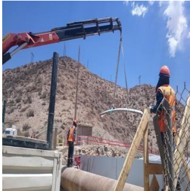
Imagen N°46 Carguío y traslado de planchas de casco 8vo anillo.
