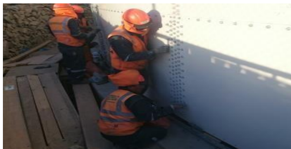
Imagen N°19 Unión de planchas de casco
