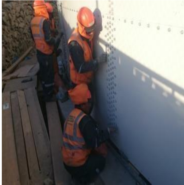
Imagen N°36 Unión empernada de planchas del 5to anillo.
