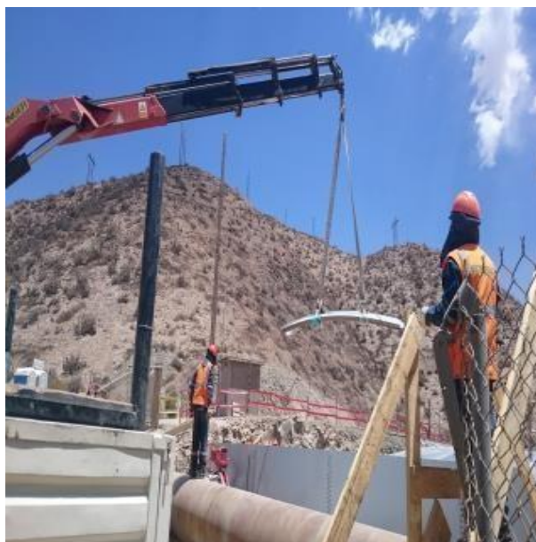
Imagen N°34 Carguío y traslado de planchas de casco 5to anillo.
