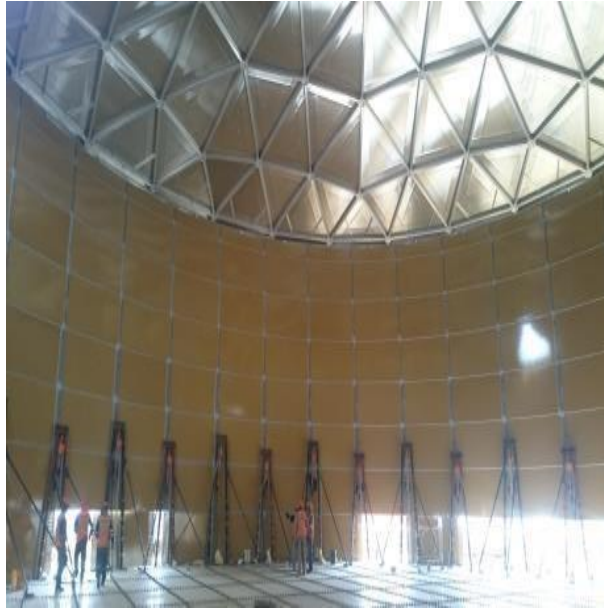
Imagen N°47 Distribución de planchas para el 8vo anillo.
