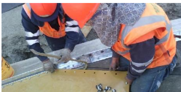
Imagen N°4 Instalación de anillo de rigidez inferior
