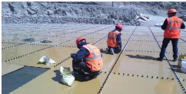
Imagen N°5 Unión de planchas de fondo
