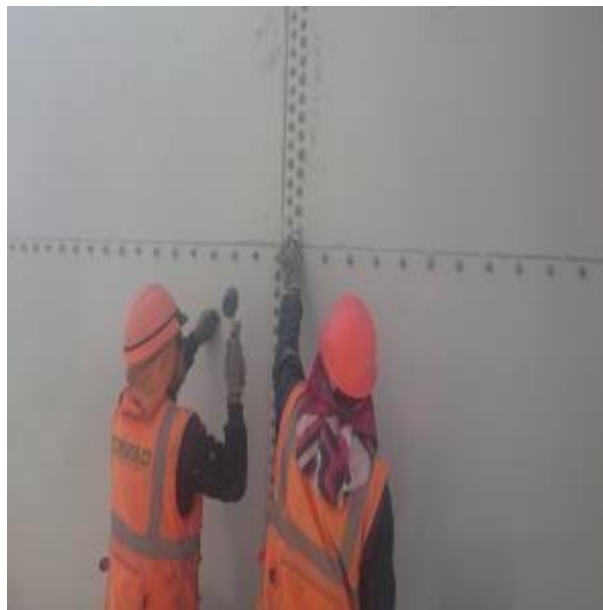
Imagen N°49 Torqueo de pernos de planchas del 8vo anillo.
