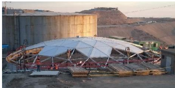
Imagen N°10 Armado de estructuras de techo tipo domo
