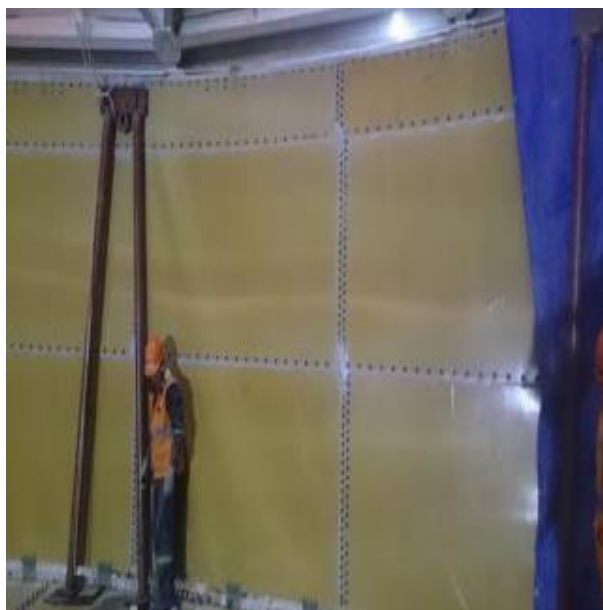
Imagen N°27 Distribución de planchas del casco 3er anillo.
