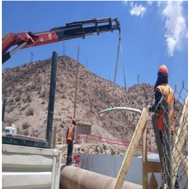
Imagen N°42 Carguío y traslado de planchas de casco 7mo anillo.
