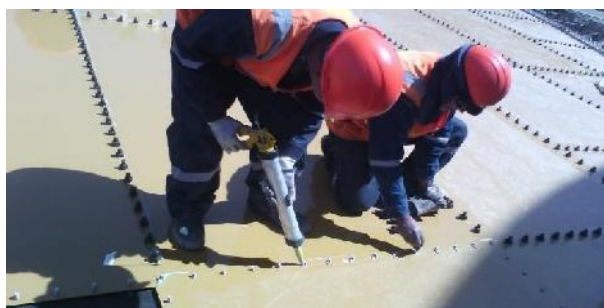
Imagen N°6 Sellado con elastomérico Sikaflex 1A a las planchas de fondo
