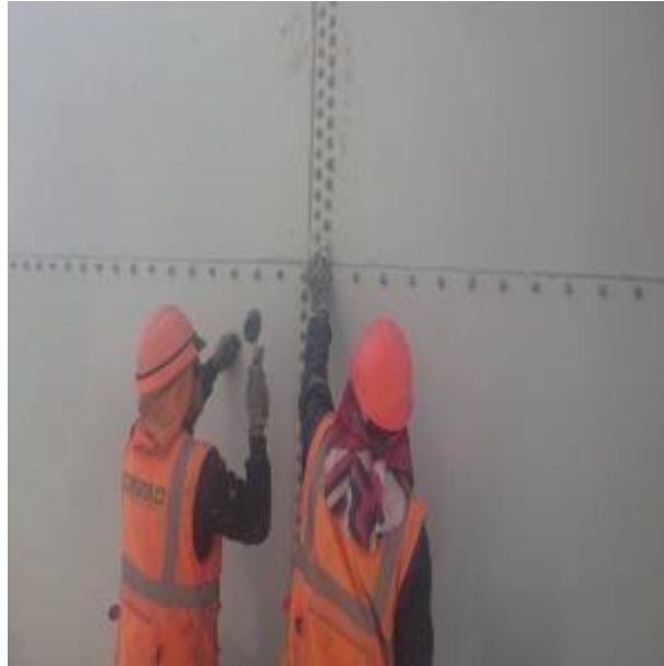
Imagen N°41 Torqueo de planchas de casco 6to anillo.
