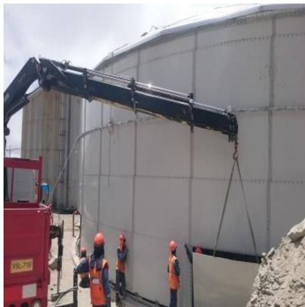
Imagen N°35 Distribución de planchas del 5to anillo.
