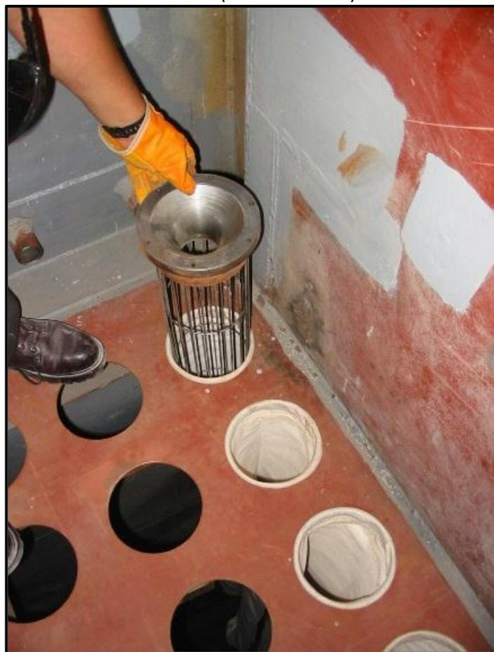
Figura 10. Colocación de canastilla
