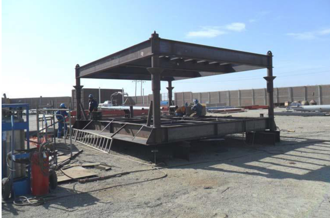
Fig. N° 6 Instalación de PLEM en amarradero Alfa – FSO Fuente: BPZ Exploración & Producción S.R.L.
