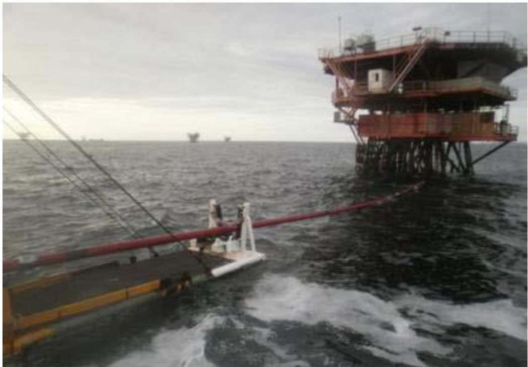
Fig. N° 7 Tendido de tuberías submarinas CX-15_CX-11, CX-15_FSO Fuente: BPZ Exploración & Producción S.R.L.
