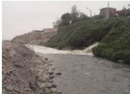
Figura 3.5.- Vertimiento del Colector 6 en el río Rímac (Foto G. Sánchez, 2006).
