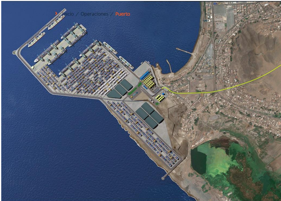
Figura 1-5: Proyecto Terminal Portuarios Chancay
