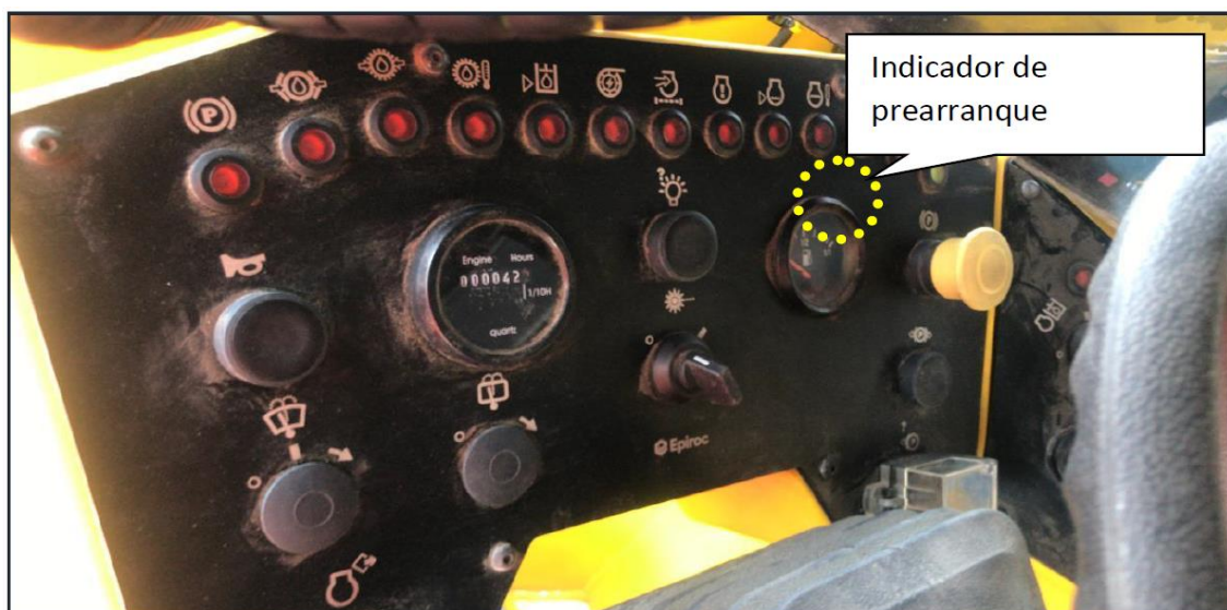
Figura 3-10: Alarma de pre-arranque en el equipo
