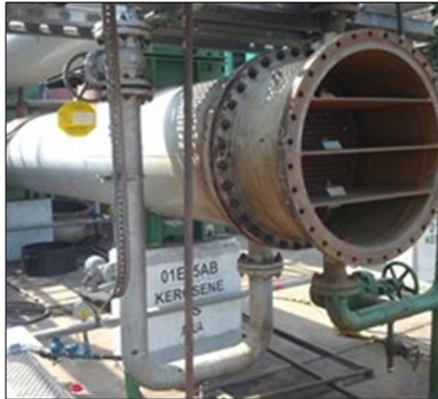
Figura 2.58: Prueba hidrostática lado casco en intercambiador 01E25B.
