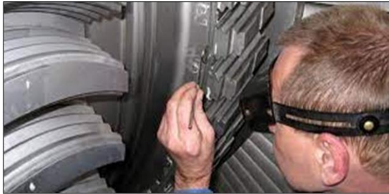
Figura 2.10: Inspección visual directa.
