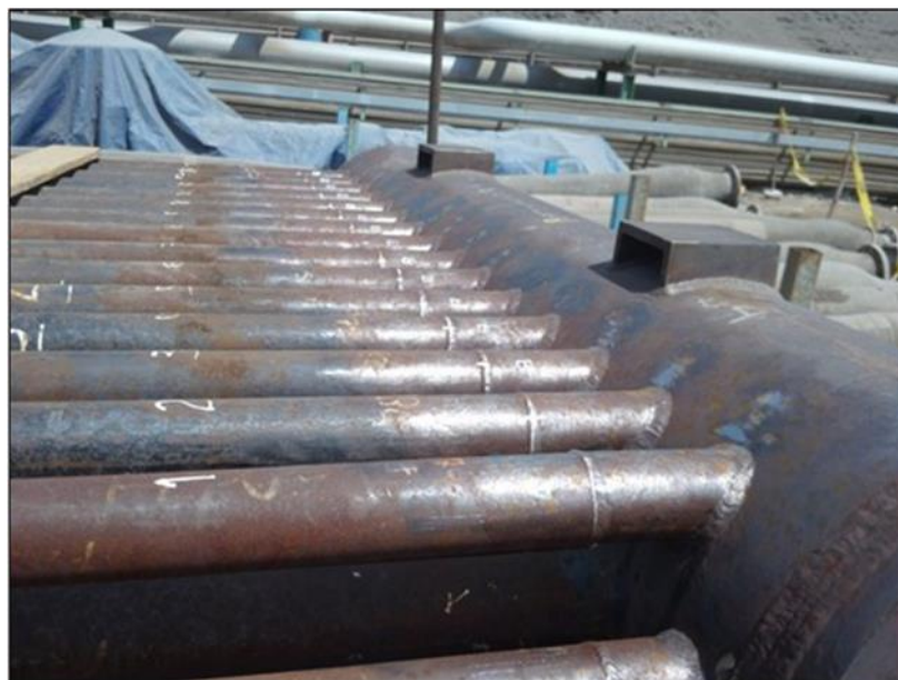
Figura 3.5: Limpieza de cordones de soldadura para la examinación visual.
