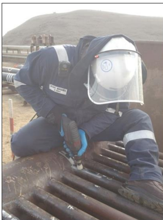
Figura 3.11: Preparación de superficie del niple y tubo del módulo 1.
