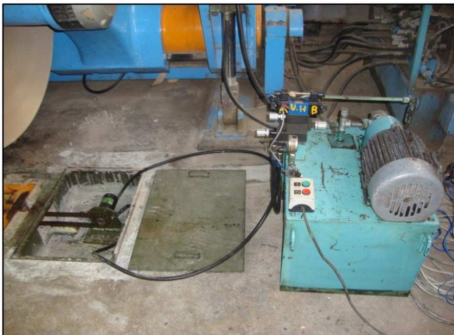
FIGURA N° 34 UNIDAD HIDRÁULICA PARA LAS PRUEBAS
