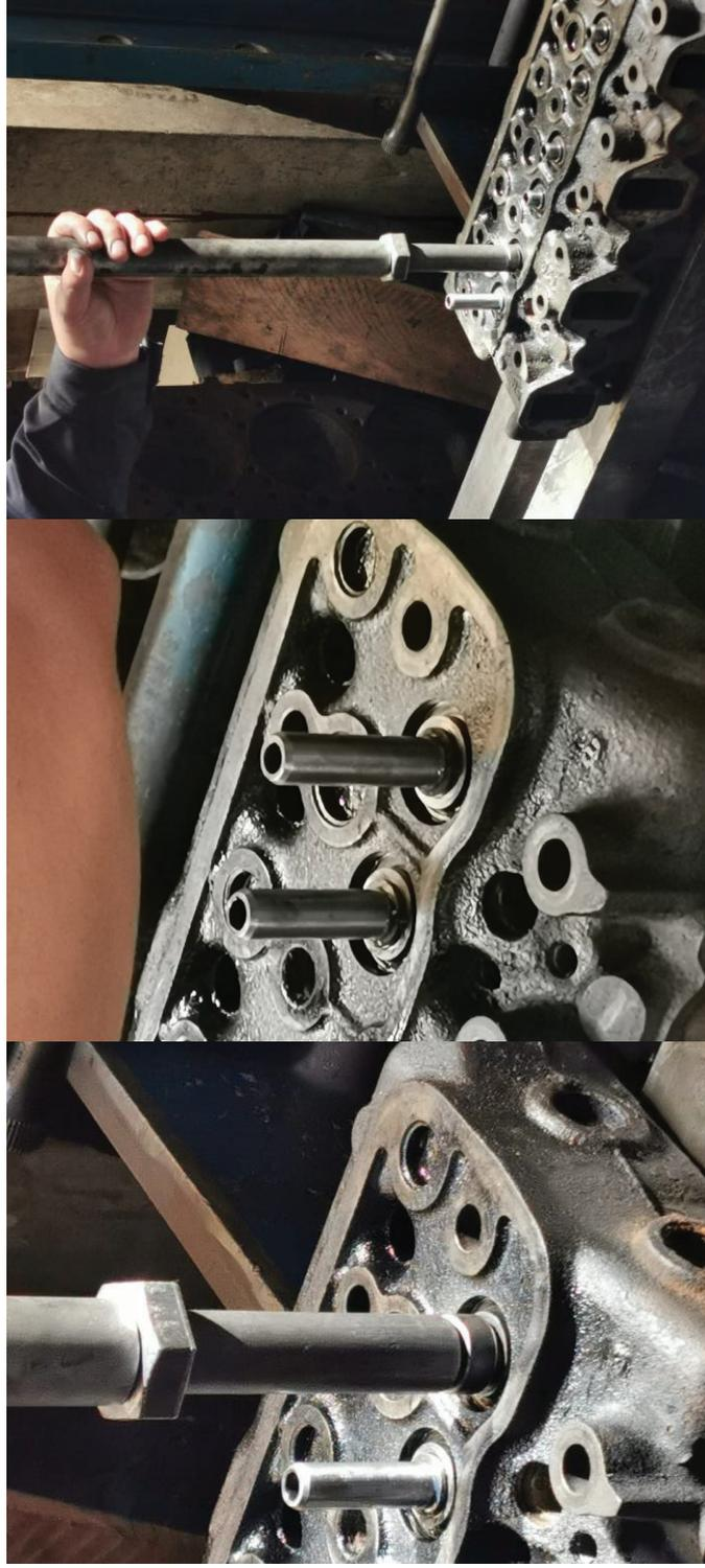
Procedimiento de instalación de guías de válvula con mandril calibrado.
