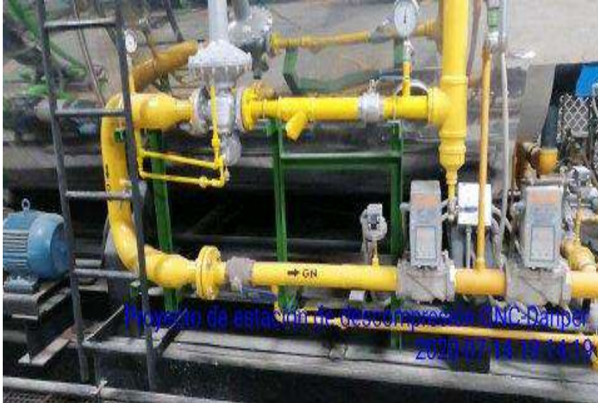
Figura 3.24: Instalación de ERS.
