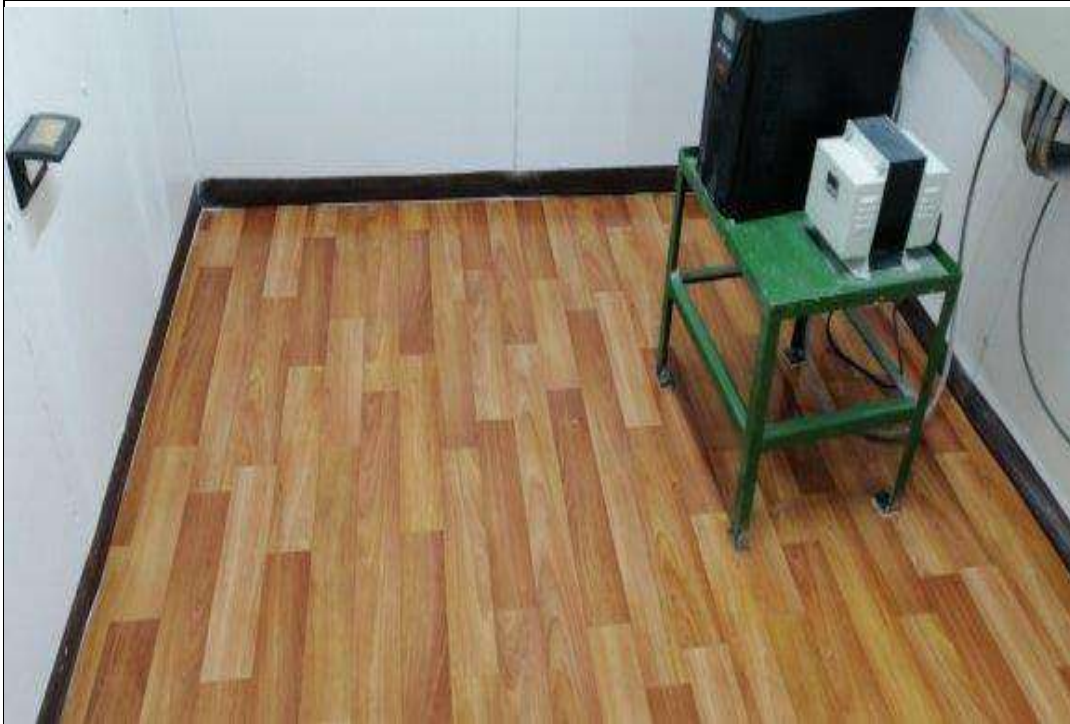
Fig. 08. Acabado parte interna de sala de control.
