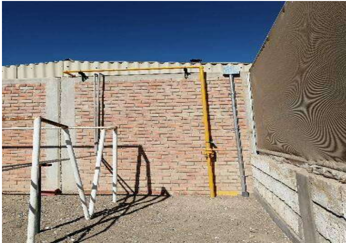
Figura 3.23: Instalación de tubería de ACERO de la red interna ingreso a sala de calderos
