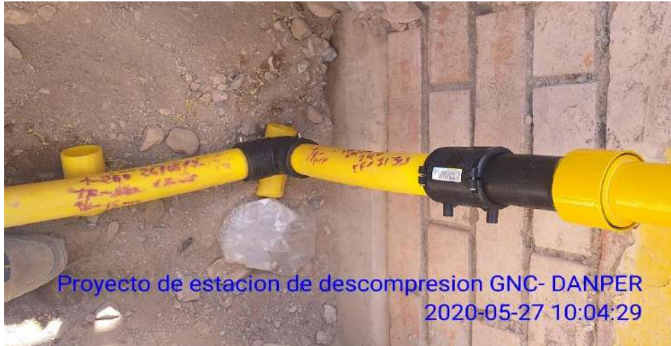
Figura 3.22: Instalación de tubería HDPE y Soldeo
