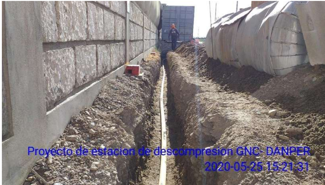
Figura 3.15: Recorrido de Zanja para tubería HDPE DN 50 mm.
