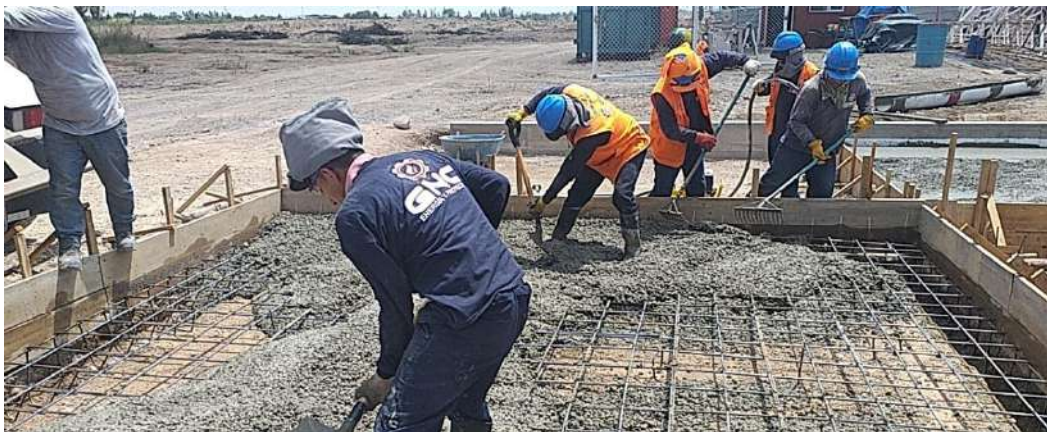
Figura 3.7: Vaciado de losa de patio de almacenamiento
