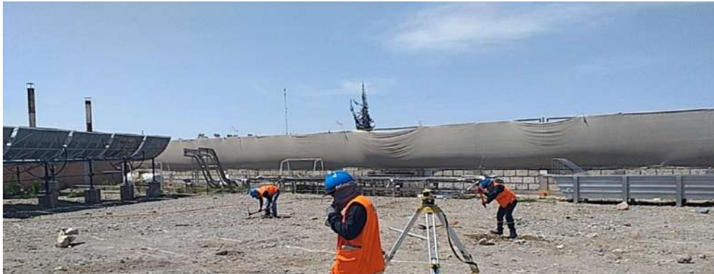
Figura 3.4: Levantamiento topográfico del terreno
