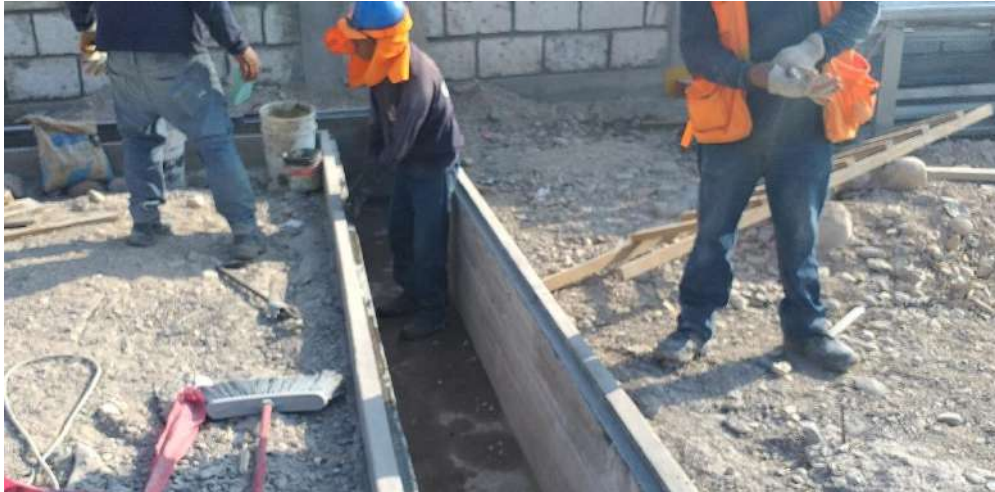
Figura 3.12: Construcción de la canaleta
