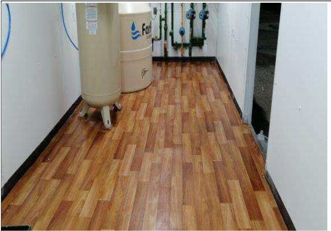
Fig. 07. Parte interna de sala de control.
