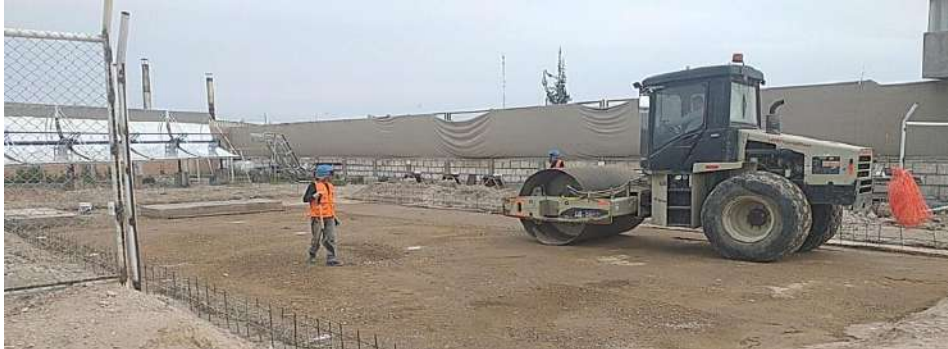
Figura 3.6: Compactación de terreno
