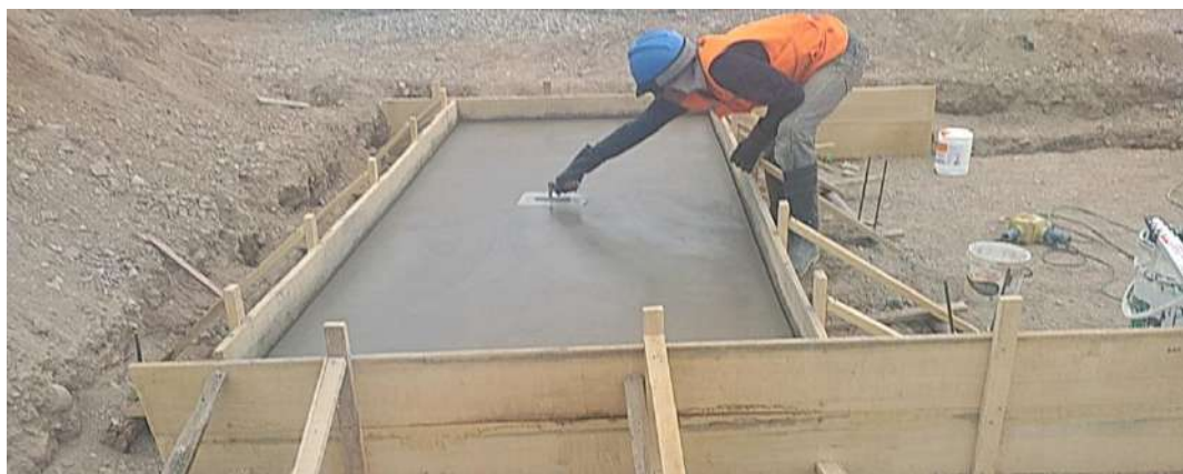
Figura 3.8: Acabado de losa de ERM
