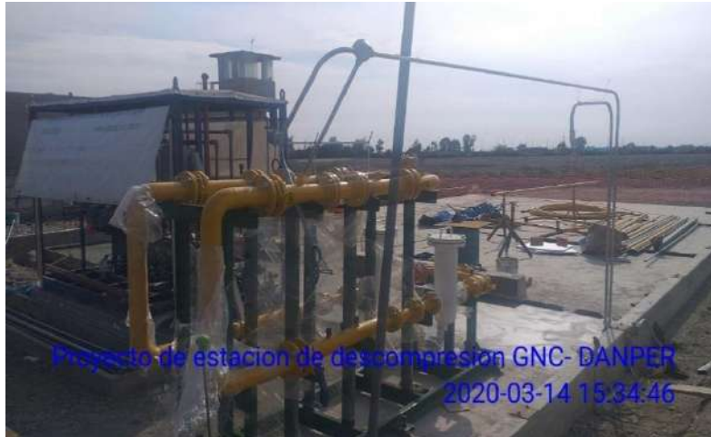
Figura 3.17: Montaje de ERM
