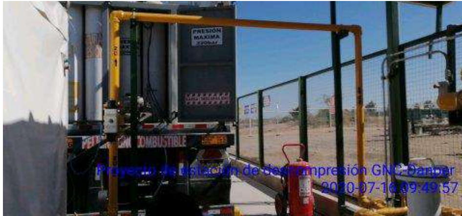
Figura 3.21: Instalación de red de Alta presión
