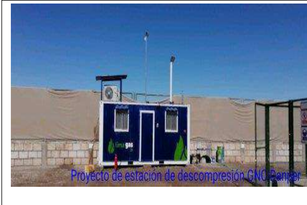
Fig. 02. Sala de control zona externa concluido.
