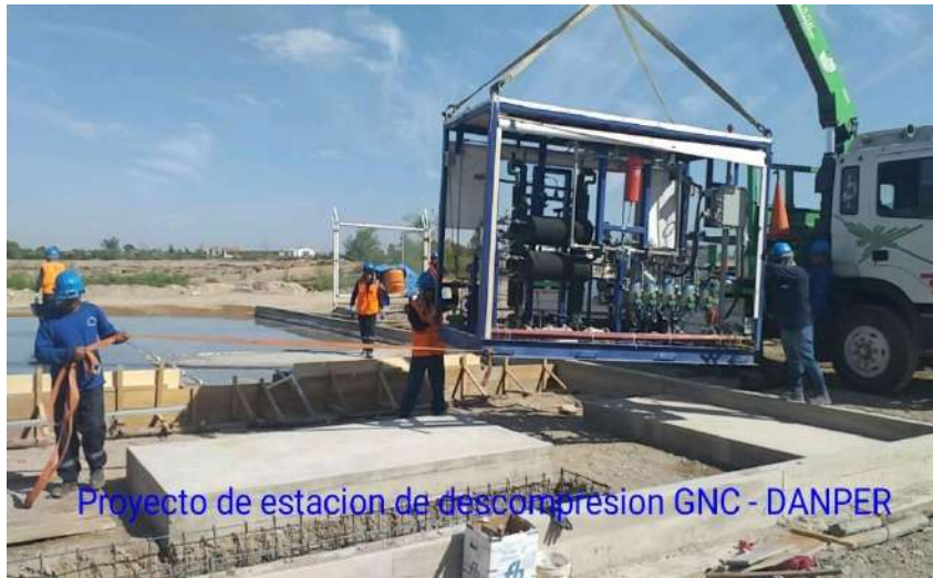
Figura 3.19: Montaje de RCU-500 Planta DANPER
