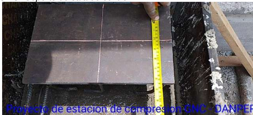
Figura 3.13: Soporte de sala de control
