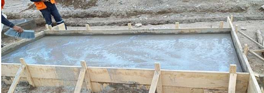
Figura 3.9: Acabado de losa de RCU-500
