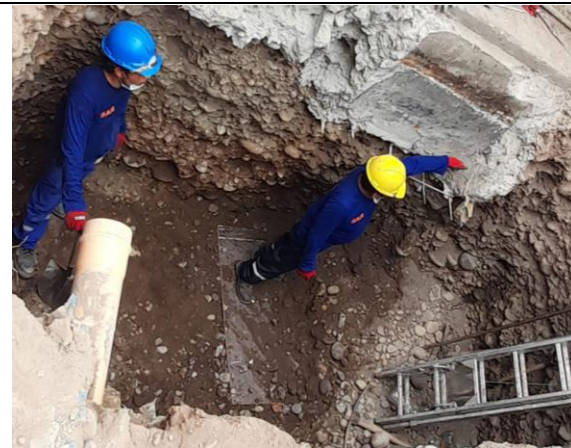
Foto 2: Perfilamiento del suelo para los trabajos de construcción.
