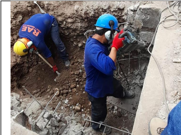
Foto 1: Inicio de los trabajos de mov. de tierras.
