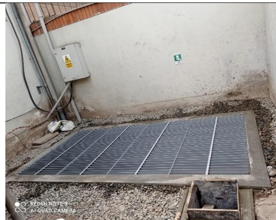
Foto 6: Entrega final del Pozo de Sedimentación.
