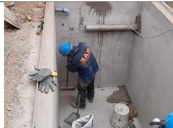
Foto 5: Limpieza interna y resane de la estructura interna del pozo.
