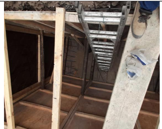
Foto 4: Armado del molde para el vaciado de concreto.
