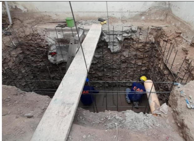
Foto 3: Armado de fierros del pozo de sedimentación.
