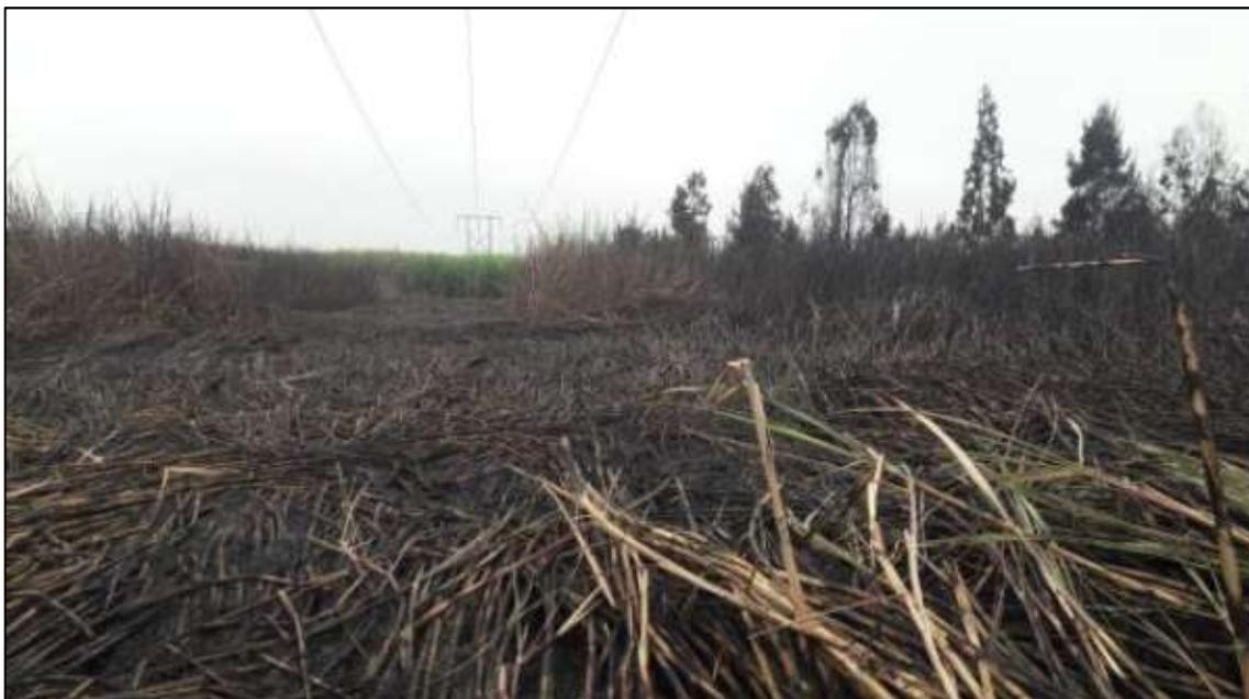
**Figura N° 2.11:** Quema de caña en L-2232 que ocasionó falla (Fuente: [4]).
