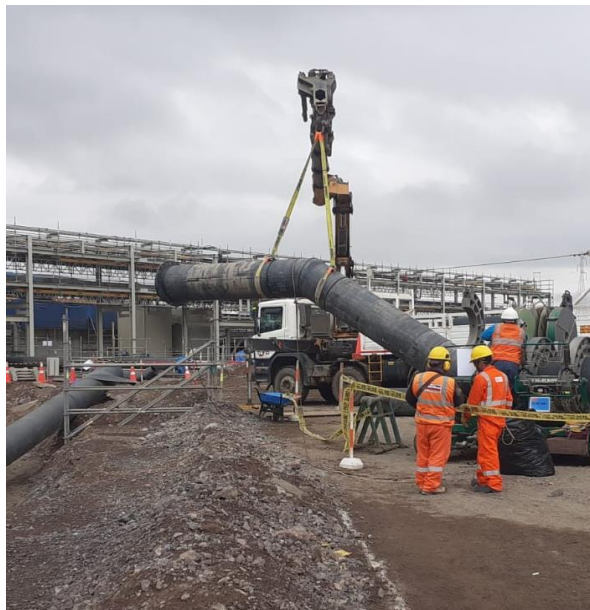
Figura 2.19 Montaje de tuberías
