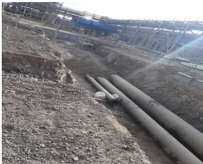
Figura 3.8 Excavación en campo para canaleta de concreto
