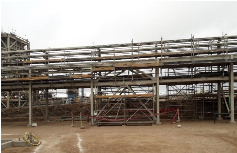
Figura 3.6 Instalación de andamios en racks de solventes
