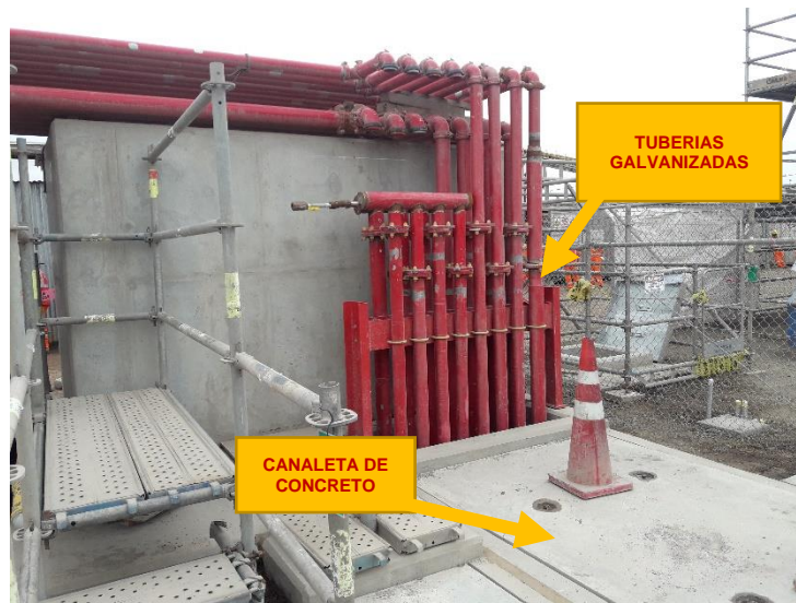
Figura 3.9 Distribución de tuberías galvanizada en canaleta
