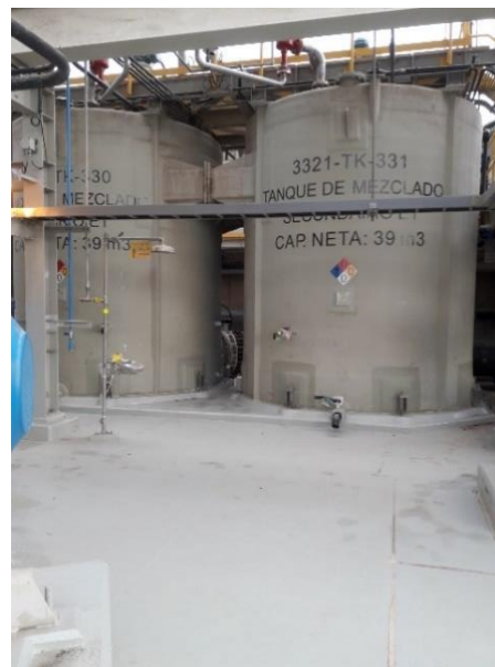
Figura 2.10 Tanque de almacenamiento de crudo
