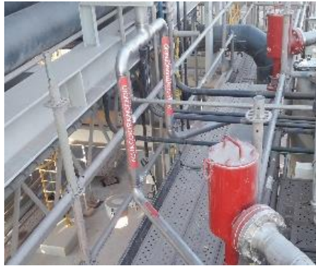
Figura 3.4 Junta de soldadura inoxidable
