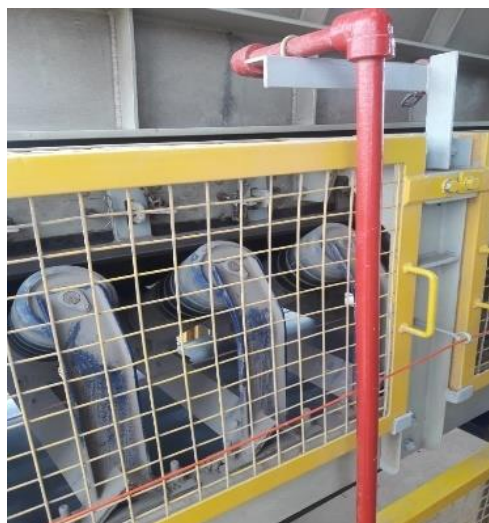
Figura 2.3 Tramo de tubería small bore
