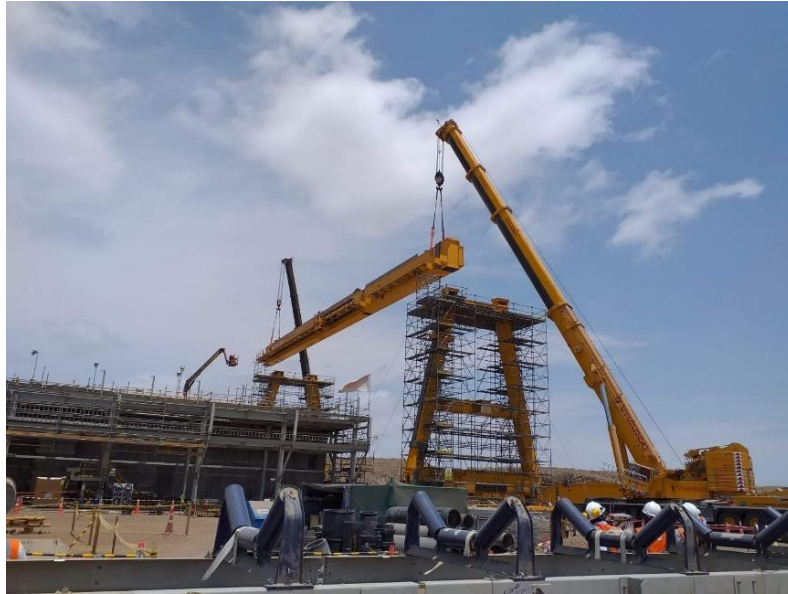
Figura 2.18 Montaje de puente grúa
