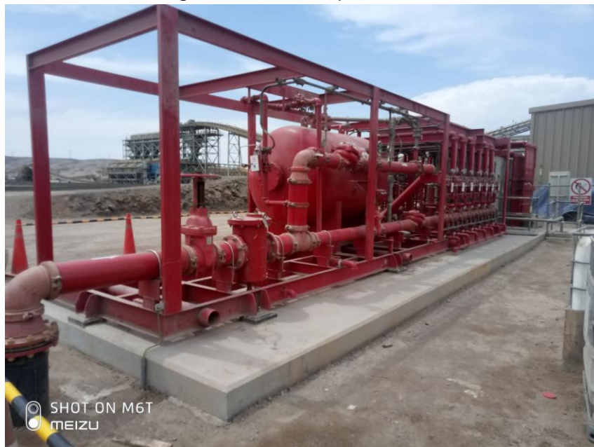
Figura 2.12 Tanque bladder de 3407L
