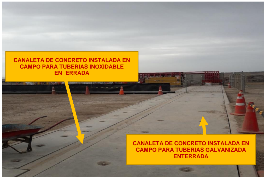
Figura 3.11 Canaleta de concreto en solventes
