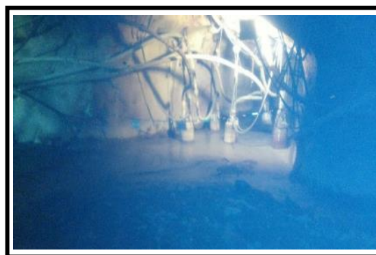
Figura N° 52 Poza de bombeo 0
