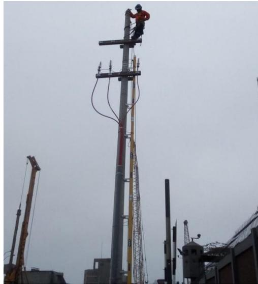
Figura N ° 3.32 Instalación de cable de bajada
