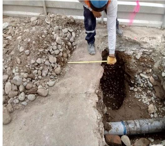
Figura N ° 3.12 Interferencias existentes
