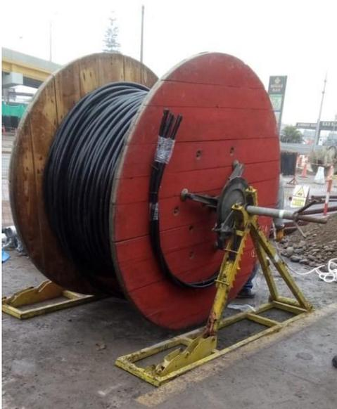
Figura N ° 3.37 Instalación de cable mensajero
