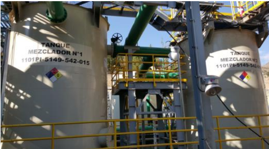
Figura 11 Tanques mezcladores
