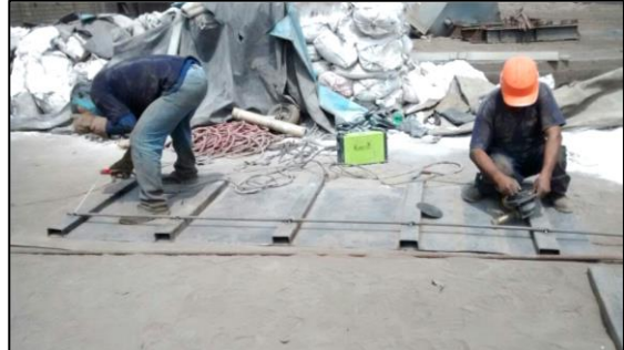
10.- Instalación de varillas de amarre
