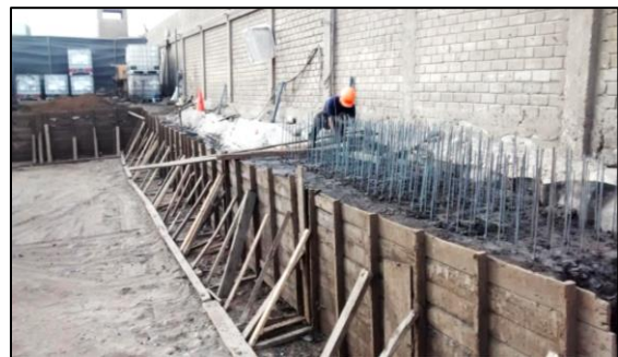
10.- Instalación de varillas de amarre
