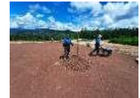
(9) Armado de chimeneas
