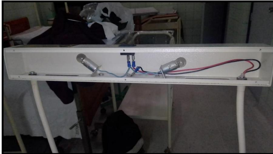
Figura 61 Estado de los focos y cables de alimentación de la iluminación auxiliar
