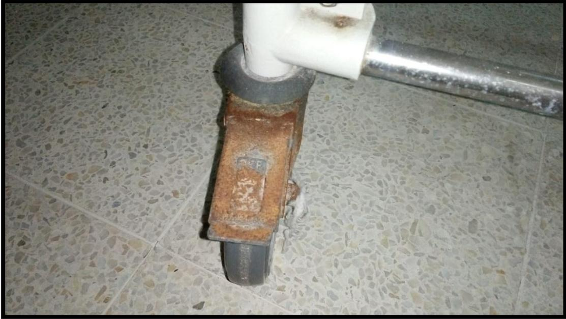
Figura 32. garruchas con oxido en el sistema de frenado
