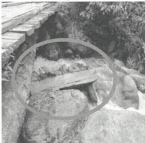
En las imágenes se muestra el dado prismático derecho deslizado aguas abajo por acción del caudal del río "La Perla".
