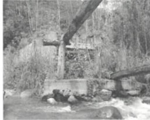
En las imágenes se muestra el dado prismático izquierdo destinado para el falso puente, con avanzada presencia de socavación y riesgo de hacer deslizado por el caudal del río "La Perla".
