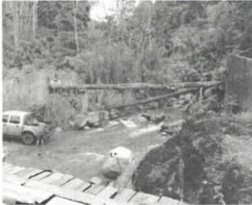
En las imágenes se muestran los restos de troncos que quedaron en el encofrado la losa viga y falso puente, las cuales fueron desmontadas por los pobladores de la zona durante el año 2015.
