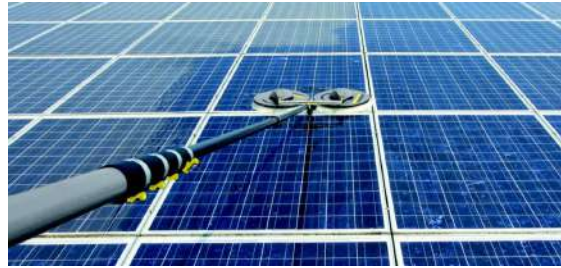
ILUSTRACIÓN 26 CEPILLO ESPECIAL CON MANGO TELESCÓPICO (FUENTE: SCHEIDER-SOLAR.DE)
