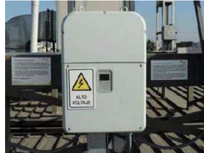
ILUSTRACIÓN 4 INVERSOR DE 33 kW (FUENTE: MINISTERIO DE ENERGÍA)
