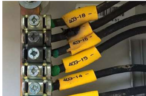
ILUSTRACIÓN 61 : SUJECIÓN INADECUADA DE LOS TERMINALES DE LOS CABLES DE STRING Y RECALENTAMIENTO DE LOS MISMOS (FUENTE: PI BERLIN AG)
