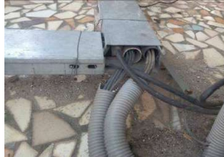
ILUSTRACIÓN 6o IZDA: SELLADO INADECUADO DE ORIFICIOS (FUENTE: PI BERLIN AG); DCHA: CUARTEAMIENTO DE LA ENVOLVENTE DEL CABLE (FUENTE: PI BERLIN AG)
