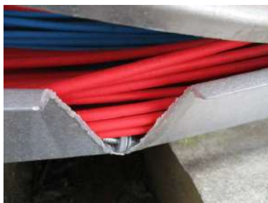
ILUSTRACIÓN 62 DAÑOS EN EL CABLEADO POR ABRASIÓN PRODUCIDA POR ARISTAS VIVAS (FUENTE: PI BERLIN AG)
