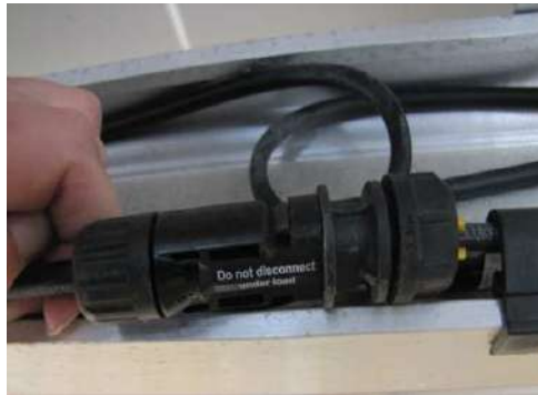
ILUSTRACIÓN 57 RADIO DE CURVATURA INSUFICIENTE (FUENTE: PI BERLIN AG)
