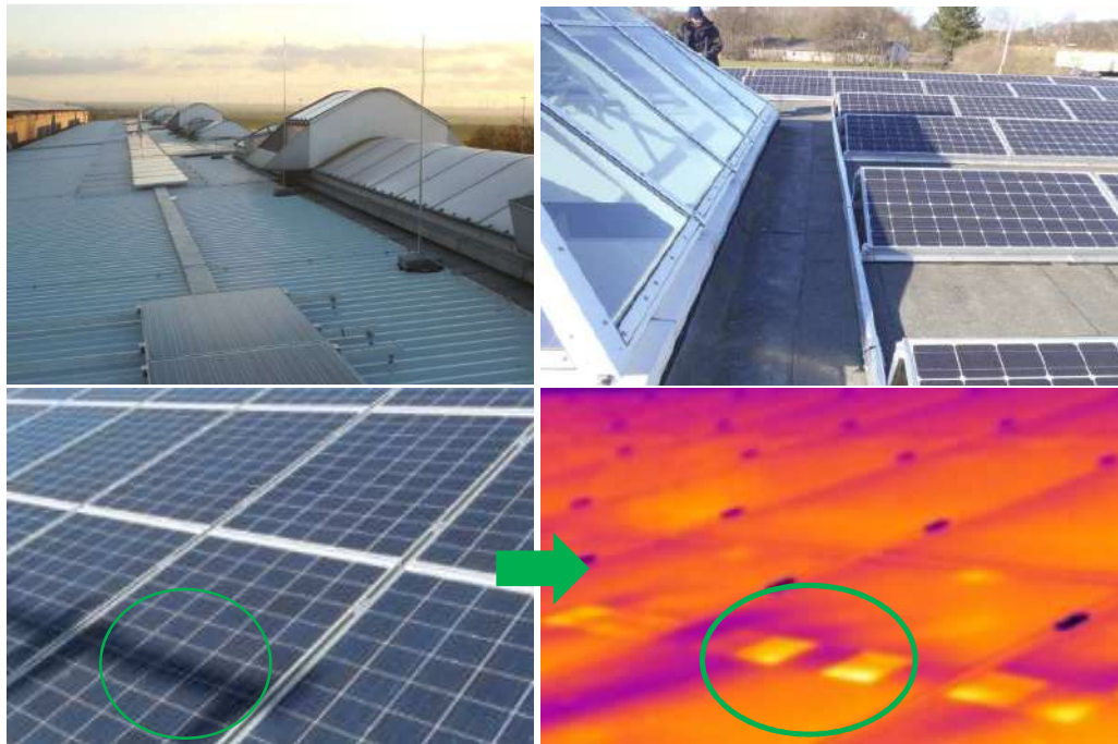
ILUSTRACIÓN 29 EJEMPLO DE MÓDULOS FV CON SOMBRAS COMO CONSECUENCIA DE LUCERNARIAS, PARARRAYOS Y LÍNEAS ELÉCTRICAS (FUENTE: PI BERLÍN AG)
