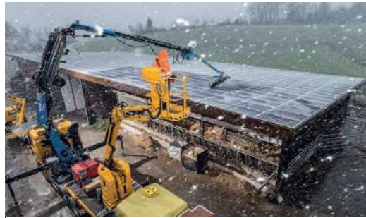
ILUSTRACIÓN 27 LIMPIEZA CON PLATAFORMA ELEVADORA (FUENTE: TOGGENBURGER.CH)
