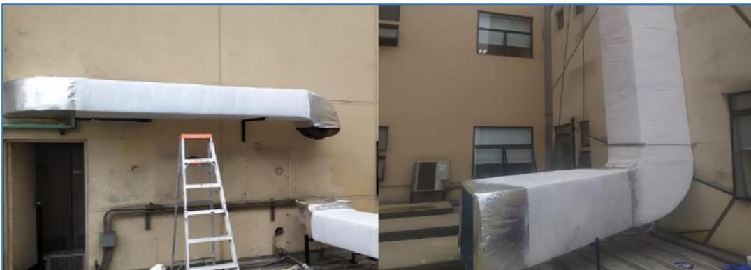
**Figura 30. Fotos de ductos enchaquetados con aislante y tela tocuyo**
