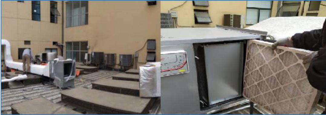
**Figura 31. Fotos del proceso de instalación de la caja porta filtro**
