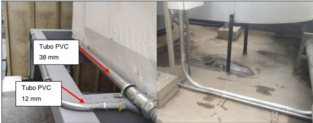
**Figura 37. Fotos de la instalación de tubos PVC de 38 mm y 12 mm**
