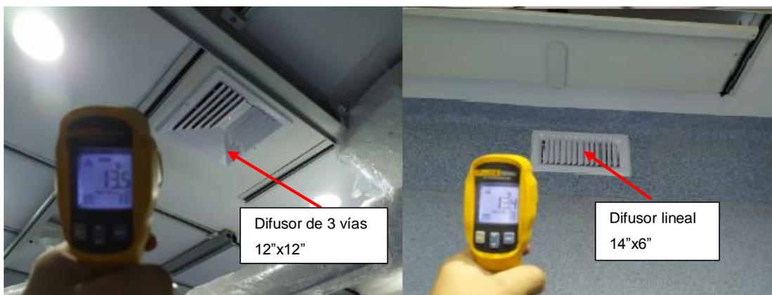
**Figura 34. Fotos de los difusores instalados en la sala de angiografía**
