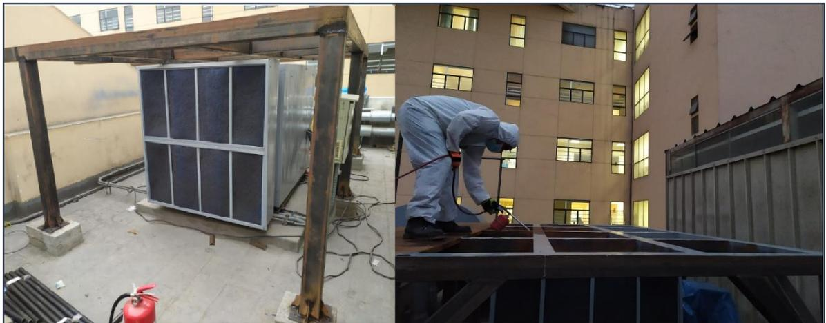
**Figura 28. Fotos de fabricación y pintado de la estructura metálica**
