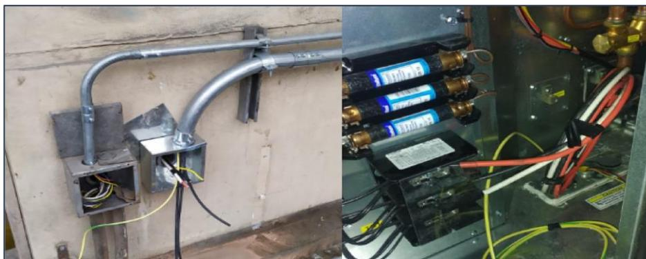
**Figura 40. Fotos del cableado eléctrico y conexionado al equipo Rooftop**
