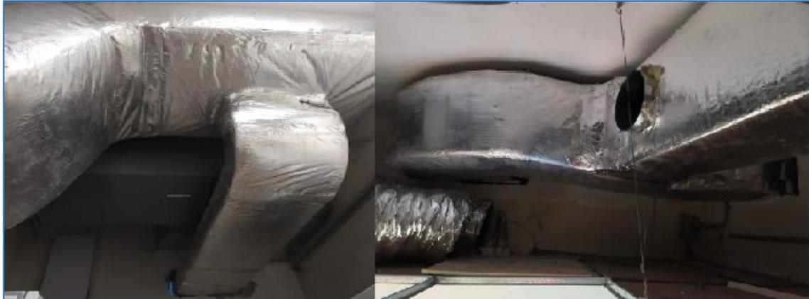
**Figura 33. Fotos del enchaquetado e instalación de los ductos interiores**
