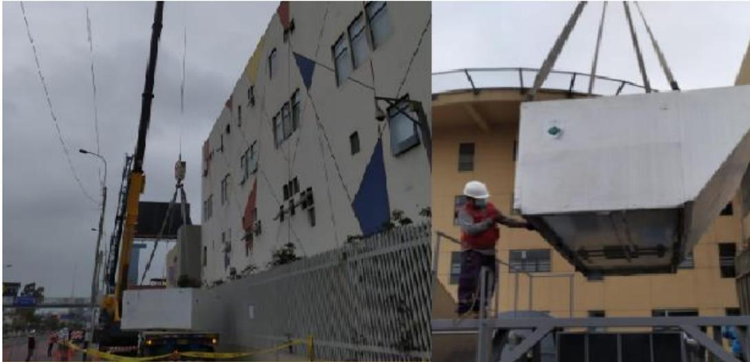
**Figura 36. Fotos del izaje y montaje del equipo Rooftop**
