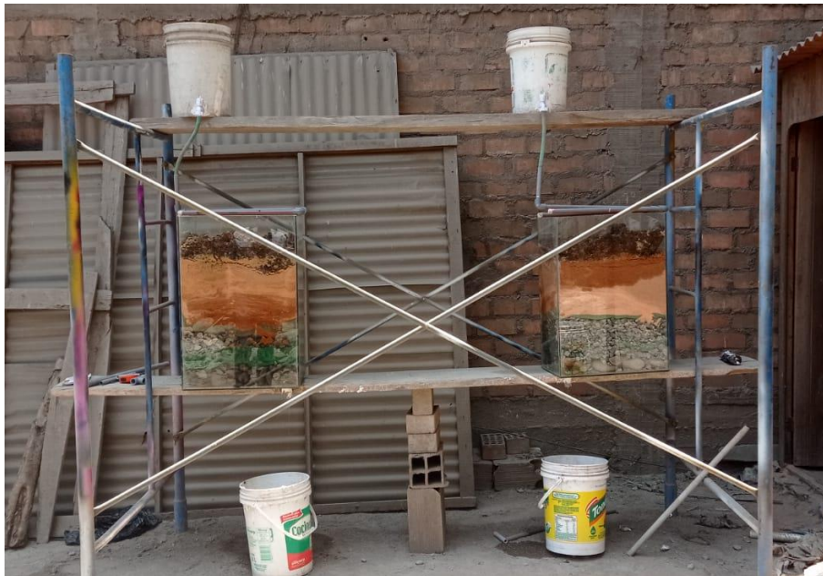
Imagen fotográfica 2: Instalación de lombrifiltro.
