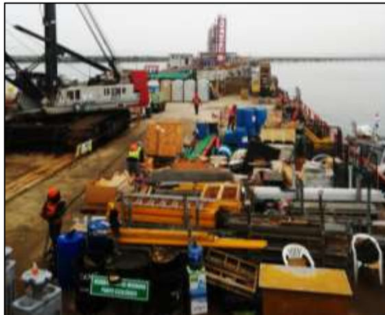
Figura 3.31 - Revisión de la eliminación de escombros
