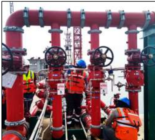
Figura 3.33 - Supervisión de la instalación de componentes
