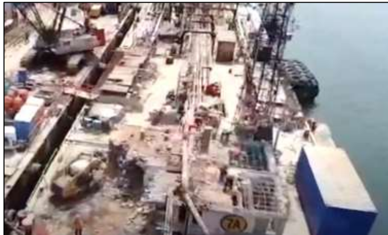
Figura 3.30 - Revisión de la demolición
