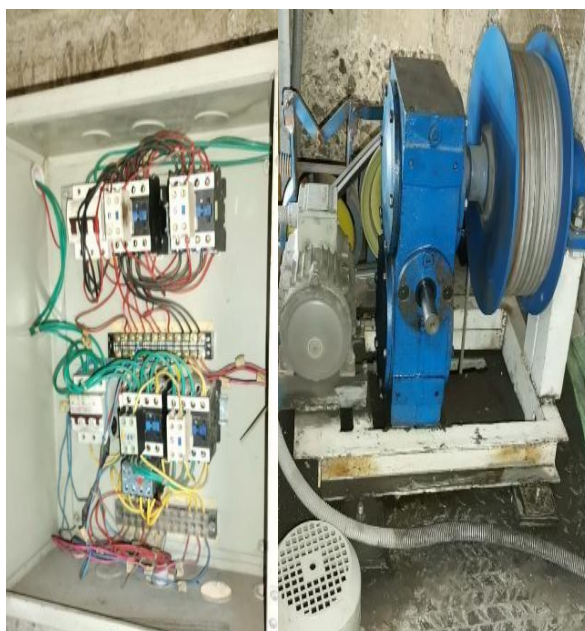
Figura 3.25. Mantenimiento de componentes eléctricos y electrónicos en Montacargas
