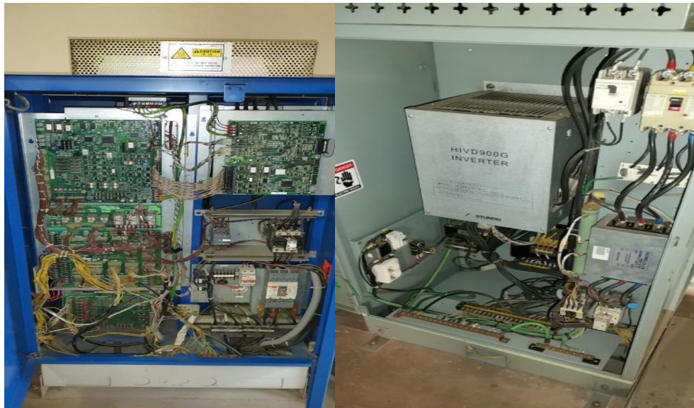
Figura 3.16: Identificar y corregir terminales de voltajes y valores de tensión. (Mayor a 220 VAC/DC), Asegurar que todo equipo este con puesta a tierra.
