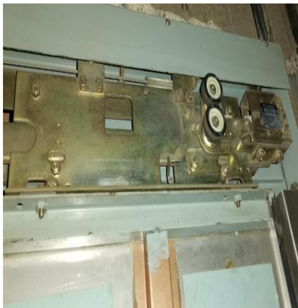
Figura 3.24. correctivos en Ruedas de suspensión, ruedas excéntricas y patines de las puertas de pasadizos
