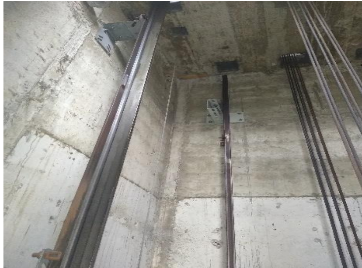
Figura 2.1: imagen del foso del ascensor
