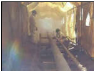
Foto N° 15: Limpieza de tubería.
