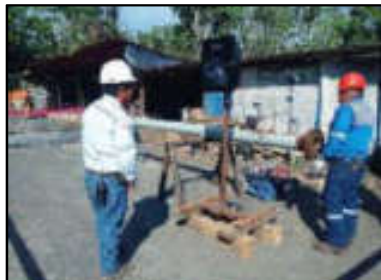
Foto N° 29: Construcción de cabezal para pruebas hidrostáticas en tubería.
