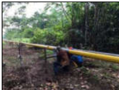
Foto N° 31: Limpieza de marco H.
