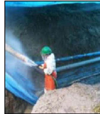
Foto N° 19: Limpieza de tubería en cruce de camino.
