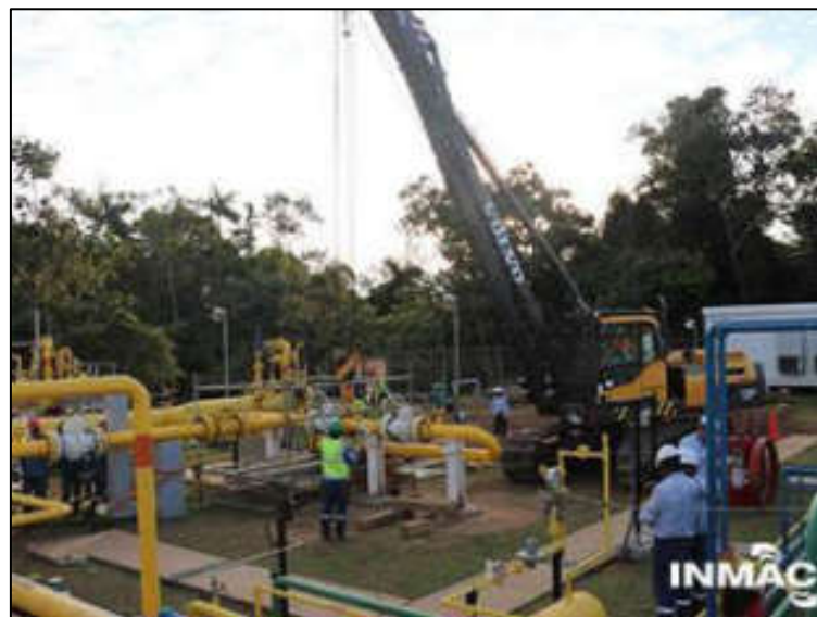
FIGURA N° 1.1. PROCESO DE INSTALACIÓN DE FLOWLINE Ø24"
