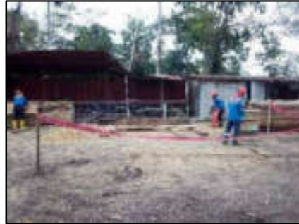
Foto N° 36: Habilitado de madera para pasarelas.
