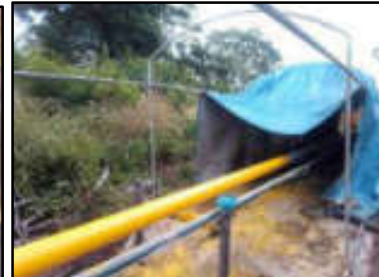
Foto N° 16: Pintado de tubería.
