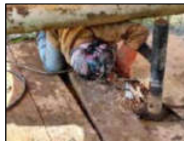
Foto N° 23: Soldeo de marco H/pilote.
