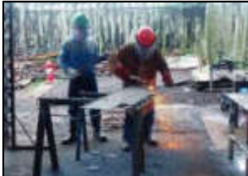
Foto N° 6: Habilitado de material.
