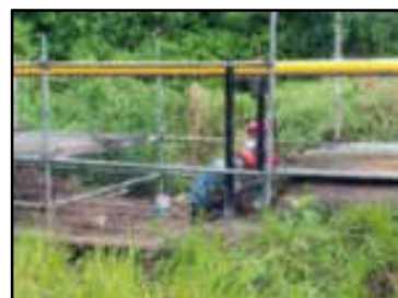
Foto N° 24: Armado de andamios para soldeo marco H/pilote en cruce de quebradas.
