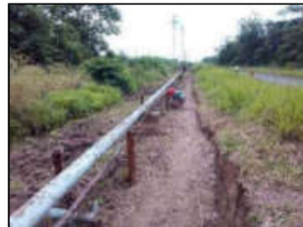
Foto N° 5: Corte de pilotes.
