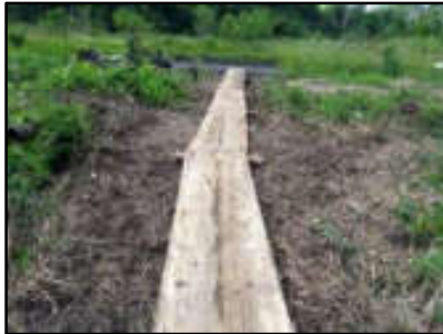
Foto N° 37: Instalación de pasarelas.
