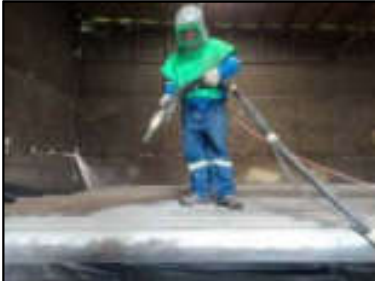
Foto N° 26: Limpieza de tubería en taller NOV
