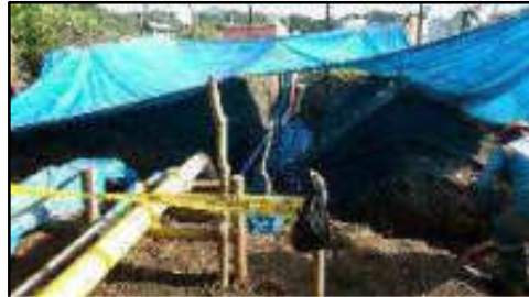
Foto N° 18: Instalación de carpa para cruce de camino.
