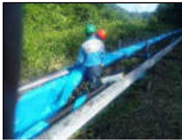
Foto N° 12: Recubrimiento de tuberías paralelas.
