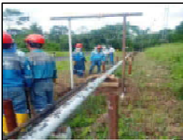
Foto N° 11: Izaje de tubería.
