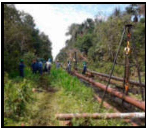
Fotos referenciales para el izaje de tubería y posterior colocación de soporte
