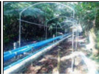
Foto N° 13: Instalación de estructura carpa para el pintado.
