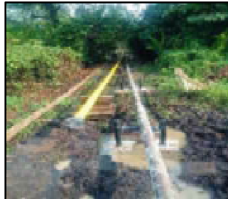
Foto N° 27: Pintado e instalación de tubería área.
