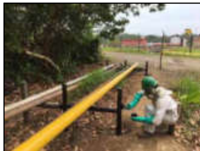
Foto N° 33: Pintado en acabado de marco H.
