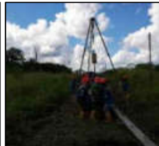
Foto N° 2: Hincado de pilote con Trípode.
