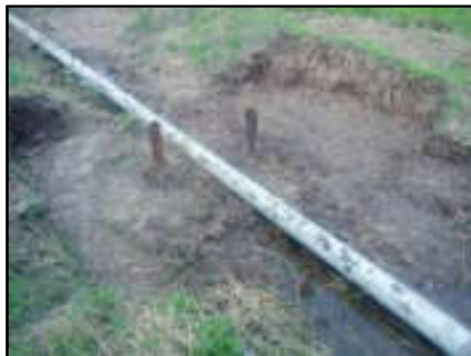
Foto N° 4: Nivelación de terreno.
