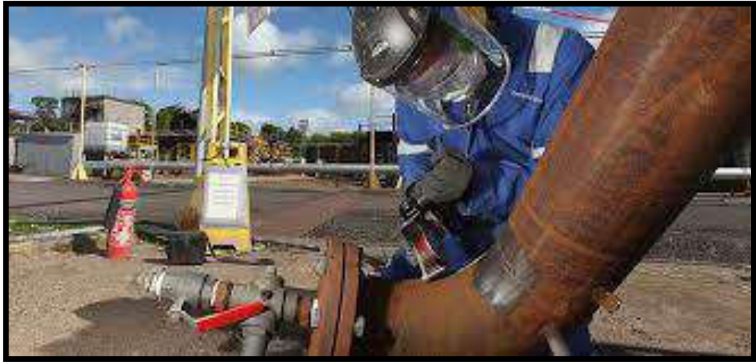
Imagen referencial de preparación de superficie
