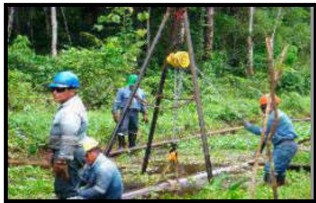
Fotos referenciales para el izaje de tubería y posterior colocación de soporte
