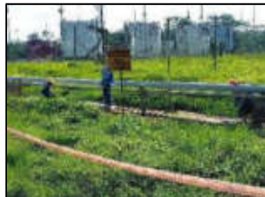
Foto N° 30: Pintado tubería en cruce 5.
