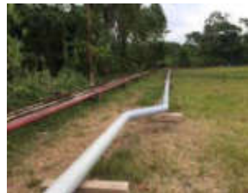
Foto N° 28: Pintado tubería en cruce 6.
