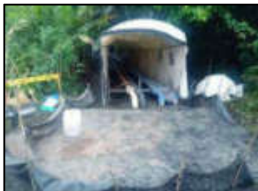
Foto N° 14: Instalación de carpa.
