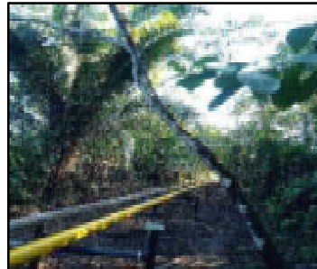
Foto N° 34: Instalación de HDPE en marco H.
