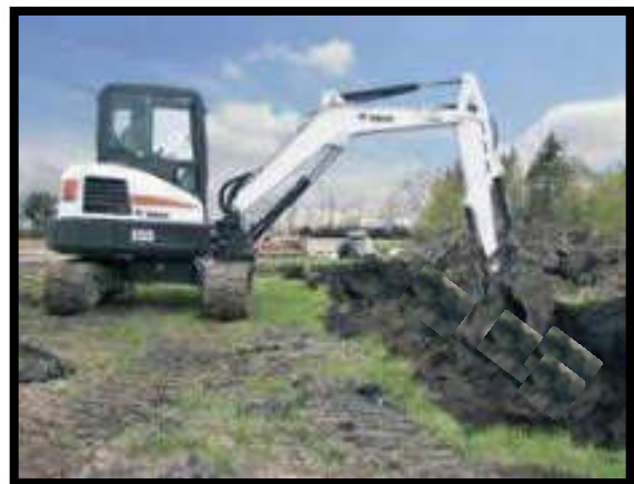
Foto referencial de habilitación de zanja para enterrado de tubería
