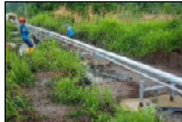
Foto N° 10: Forrado de marco H, para pintado de tubería.
