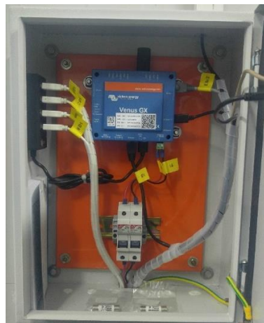
Figura N° 39: Instalación del Tablero TCM
