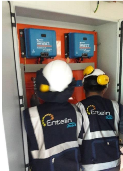
Figura N° 37: Instalación de Tablero TCP1
