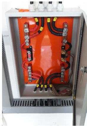
Figura N° 35: Montaje y conexionado de Tablero TCP3
