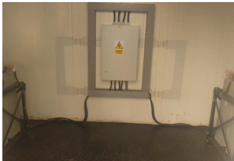
Figura N° 36: Tablero TCP3 y canalización instalada.
