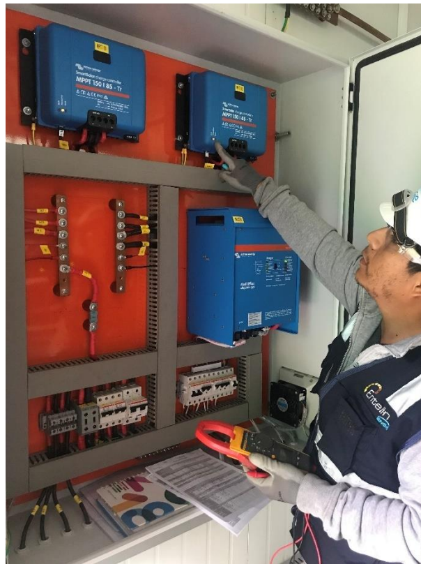
Figura N° 41: Toma de mediciones para el protocolo de prueba.
