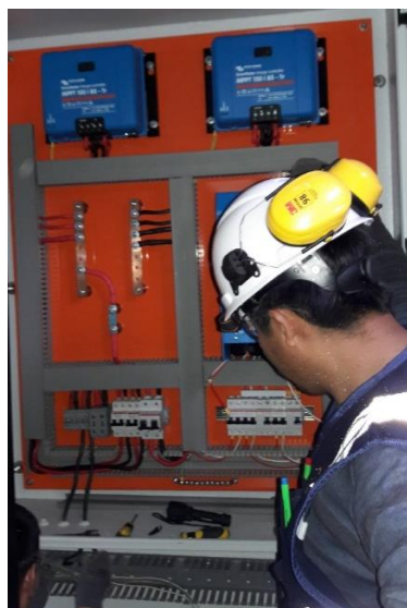
Figura N° 38: Instalación de Tablero TCP2
