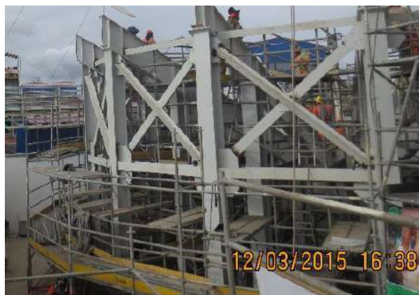
Montaje de arriostres
