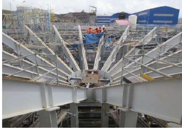
Montaje de vigas radiales
