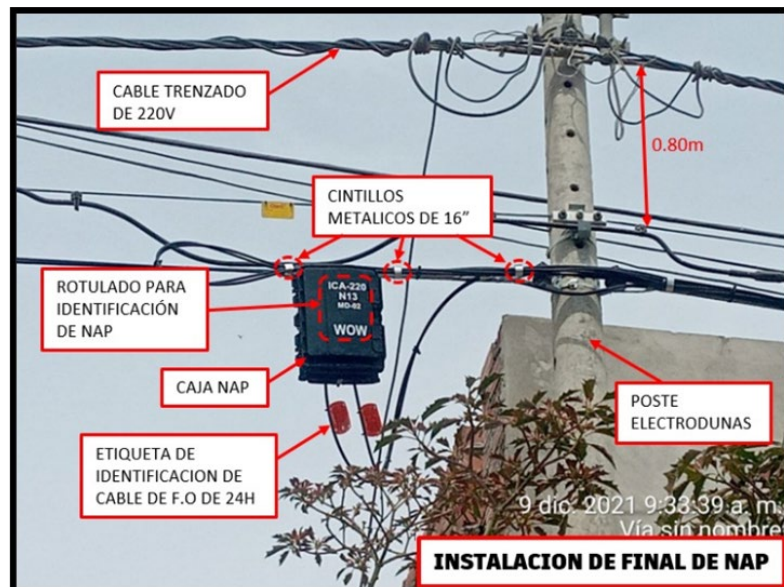
Fig. N.º 68: "Instalación de caja NAP en poste"
