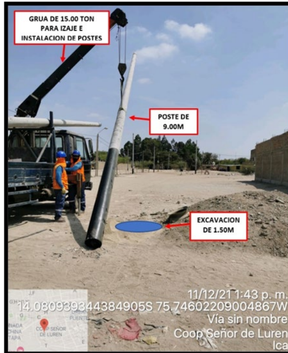
Fig. N.º 49: “Personal de planta externa realizando plantado de poste con una grúa de 15.00 Ton”
