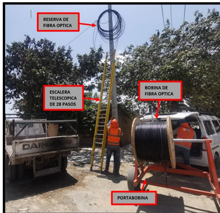
Fig. N.º 57: “Personal de tendido de fibra óptica realizando actividades”
