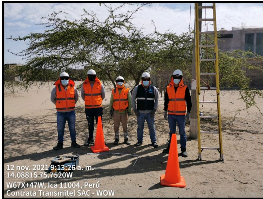
Fig. N.º 56: “Personal de tendido de fibra óptica con escalera telescópica”
