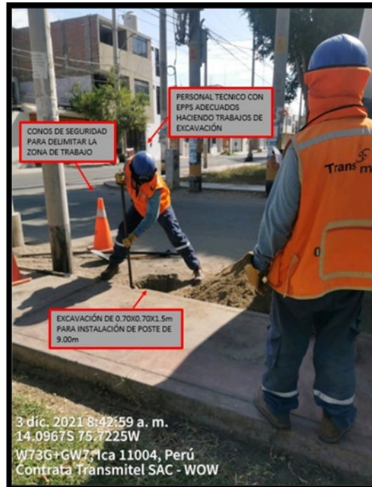
Fig. N.º 48: “Personal de planta externa realizando trabajos de obra civil para plantado de poste”
