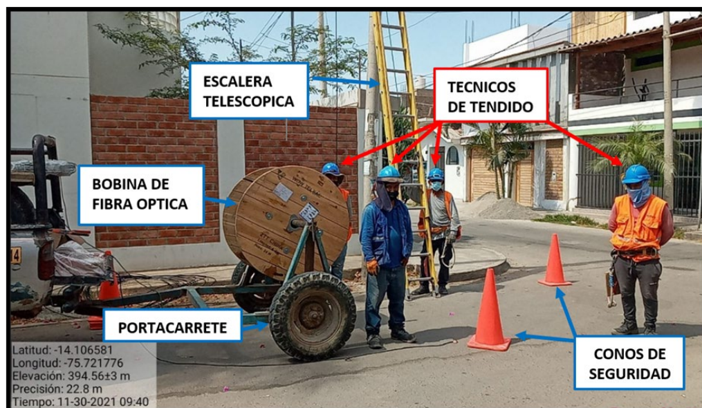
Fig. N.º 54: “Personal de tendido de fibra óptica con bobina de fibra óptica”
