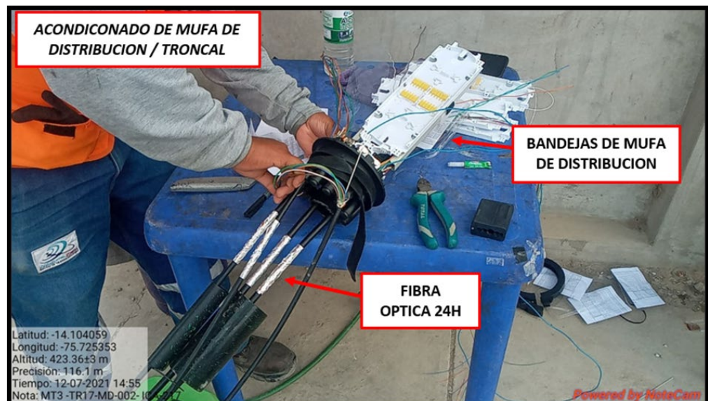
Fig. N.º 60: “Personal de tendido de fibra óptica acondicionado de mufa troncal 01”
