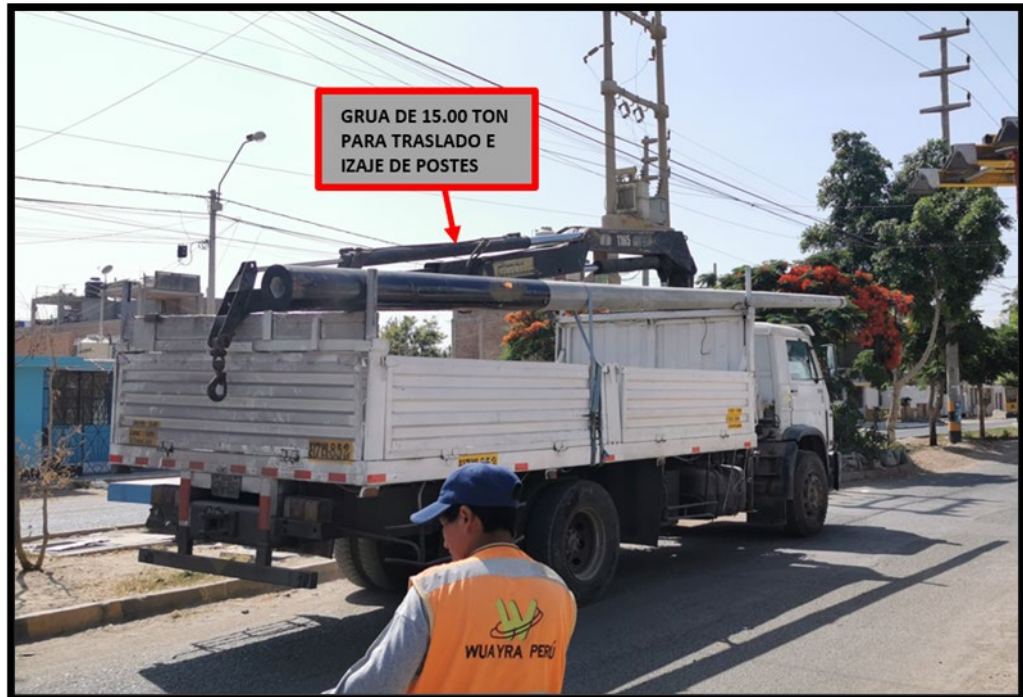
Fig. N.º 50: “Grúa para izaje y plantado de postería de telecomunicaciones, llevando los postes hacia la zona de trabajo”
