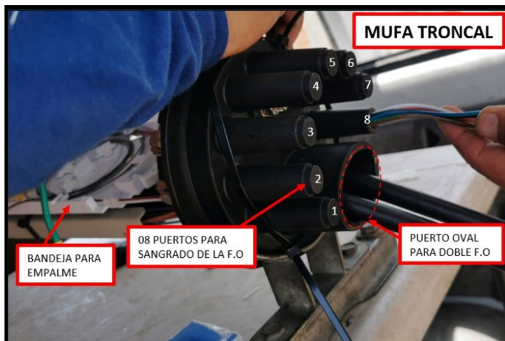
Fig. N.º 61: "Fotografía de puertos de distribución y derivación de la MT01"
