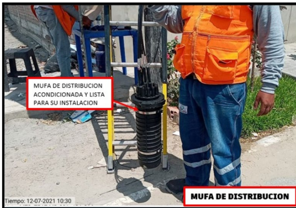
Fig. N.º 64: "Mufa de distribución acondicionada lista para ser instalada en poste"
