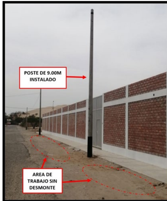
Fig. N.º 53: “Poste plantado con el área de trabajo limpia”
