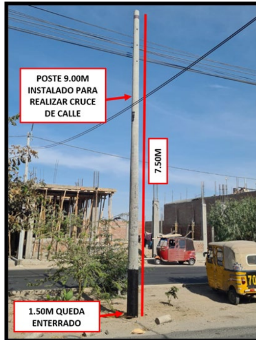
Fig. N.º 51: “Infraestructura de concreto (poste de telecomunicaciones) instalado para realizar cruce de vía”
