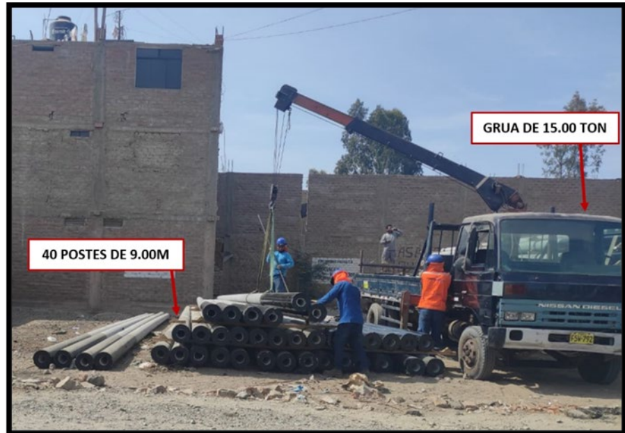
Fig. N.º 52: "Personal de planta externa realizando el traslado de postería hacia grúa de 15.00 Ton."
