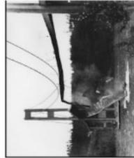
El flujero es una inestabilidad aerodinámica por la cual una estructura al vibrar absorbe energía del fluido circundante, de tal forma que es incapaz de disipar en un ciclo de vibración toda la energía que absorbe. La superficie aerodinámica está bajo la acción de la carga inducida por la sustentación.
