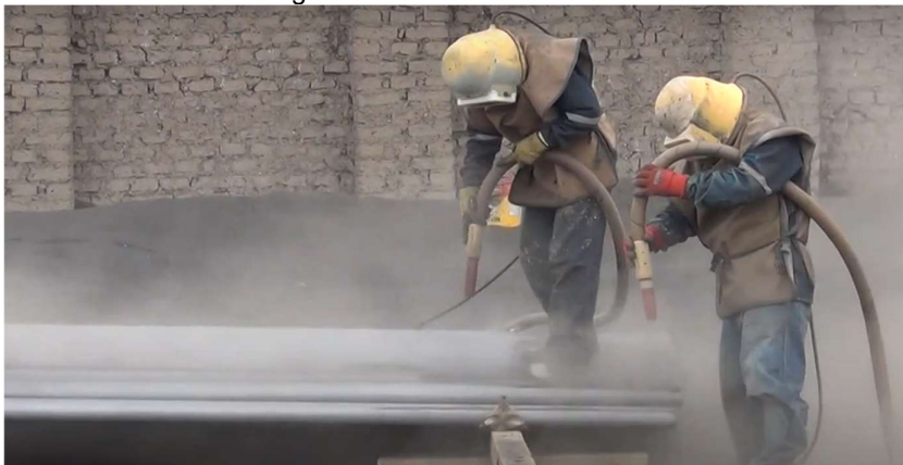
Figura 3.14 Arenado de tubería
