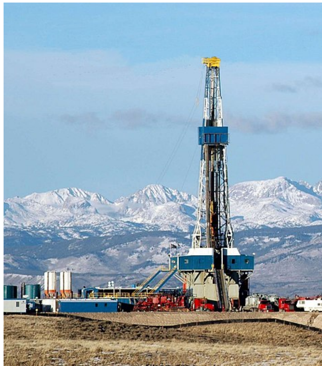
Figura 1: Torre de perforación.
