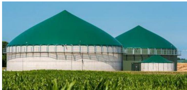
Figura 4 Sistema de biodigestor continuo
